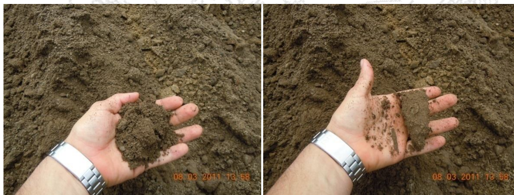
Figura 11: Sustitución de material de subrasante, material evaluado en laboratorio. Fuente: LanammeUCR, 2011.
