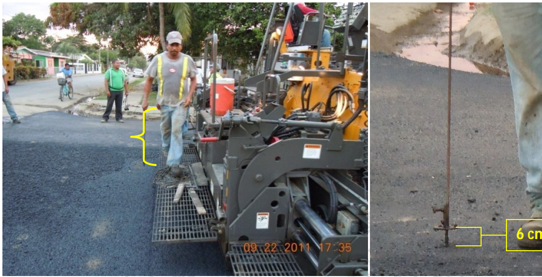
Figura 36: Verificación de espesores de carpeta Fuente: LanammeUCR, 2011.
