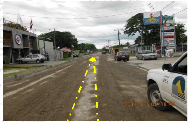
Figura 27: Desprendimientos puntuales y zonas con deficiente compactación. Fuente: LanammeUCR, 2011.
