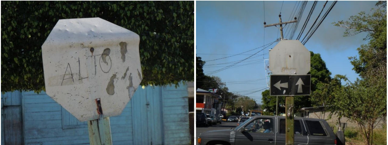
Figura 49: Mal estado de las señales de tránsito.
