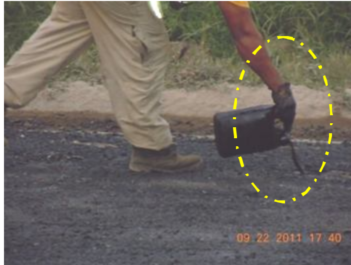
Figura 34: Aplicación de emulsión a mano Fuente: LanammeUCR, 2011.
