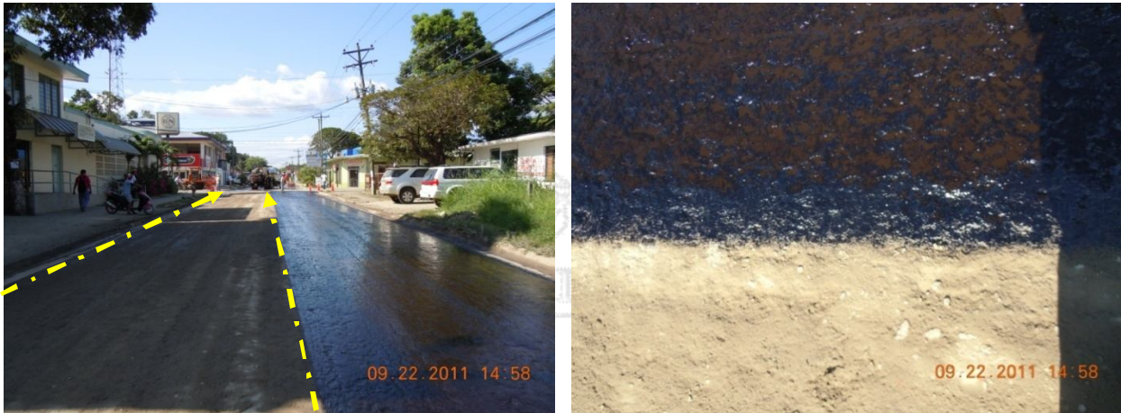
Figura 30: Aplicación de ligante asfáltico previo a la colocación de la carpeta asfáltica Fuente: LanammeUCR, 2011.
