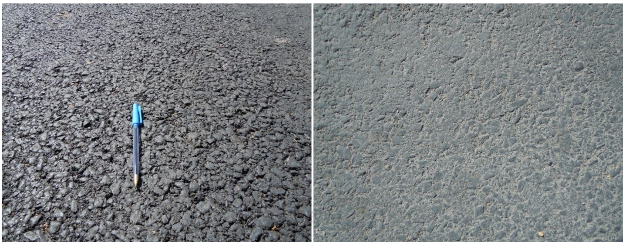
Figura 43: Comparación entre la apertura de la mezcla colocada en el mes de diciembre (izquierda) y la colocada anteriormente en otra vía del casco urbano (derecha).
