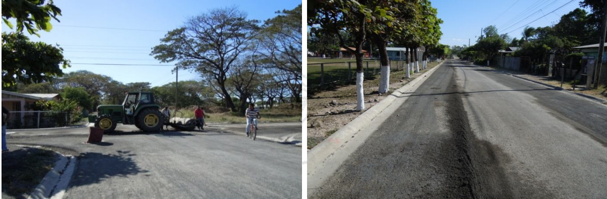
Figura 46: Proceso de barrido de las vías con tratamiento superficial Fuente: LanammeUCR, 2011.
