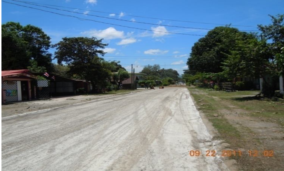
Figura 29: Condiciones de la base colocada, sector norte Filadelfia. Fuente: LanammeUCR, 2011.
