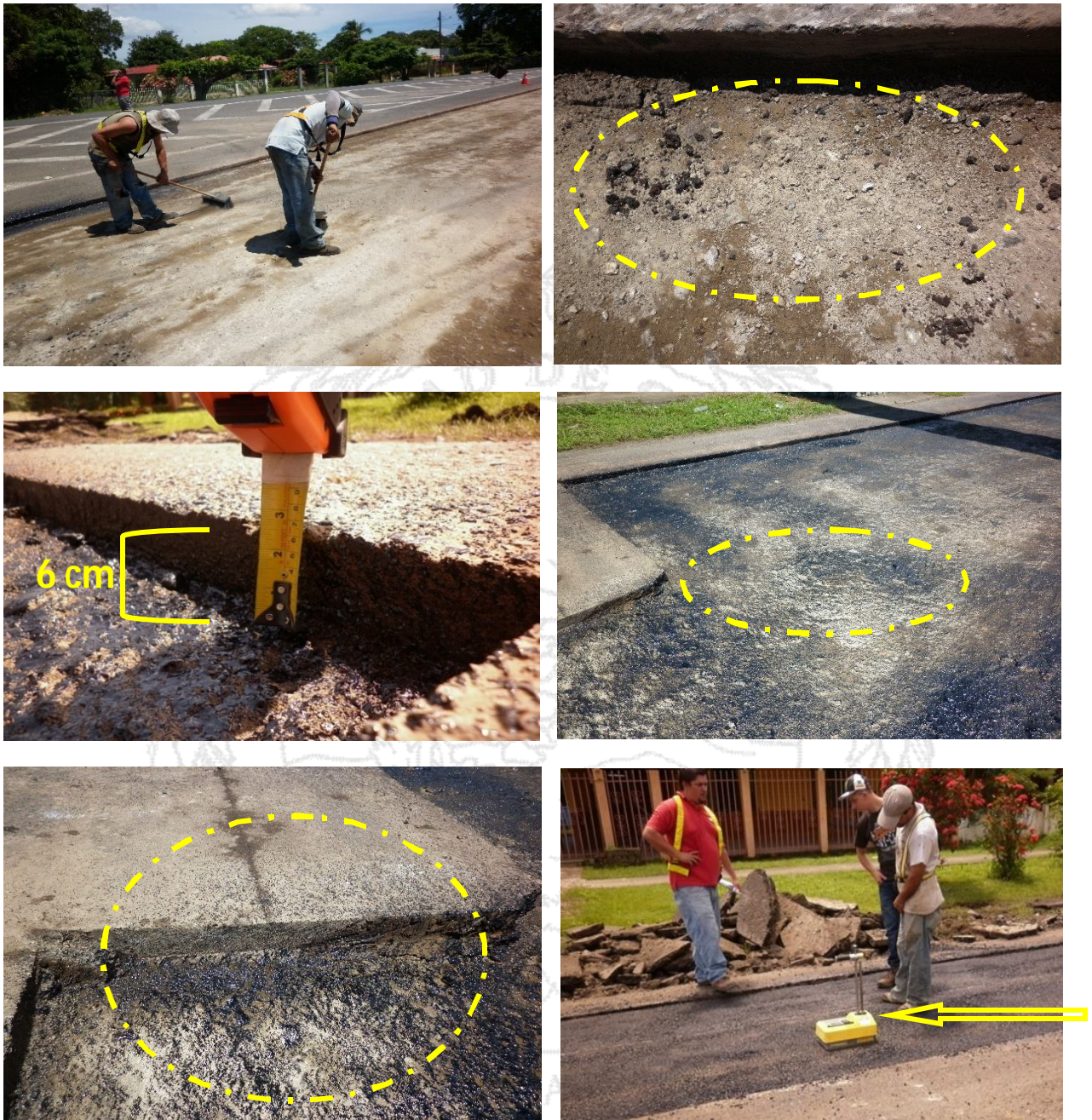
Figura 10: Proceso de ejecución de paño de prueba para bacheo en sector norte. Fuente: LanammeUCR, 2011.
