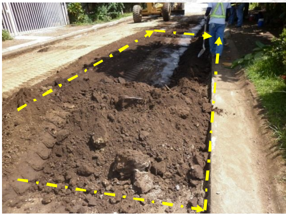
Figura 6: Estructuras existentes insuficientes. Sustitución de material de subrasante con material granular. Fuente: LanammeUCR, 2011.
