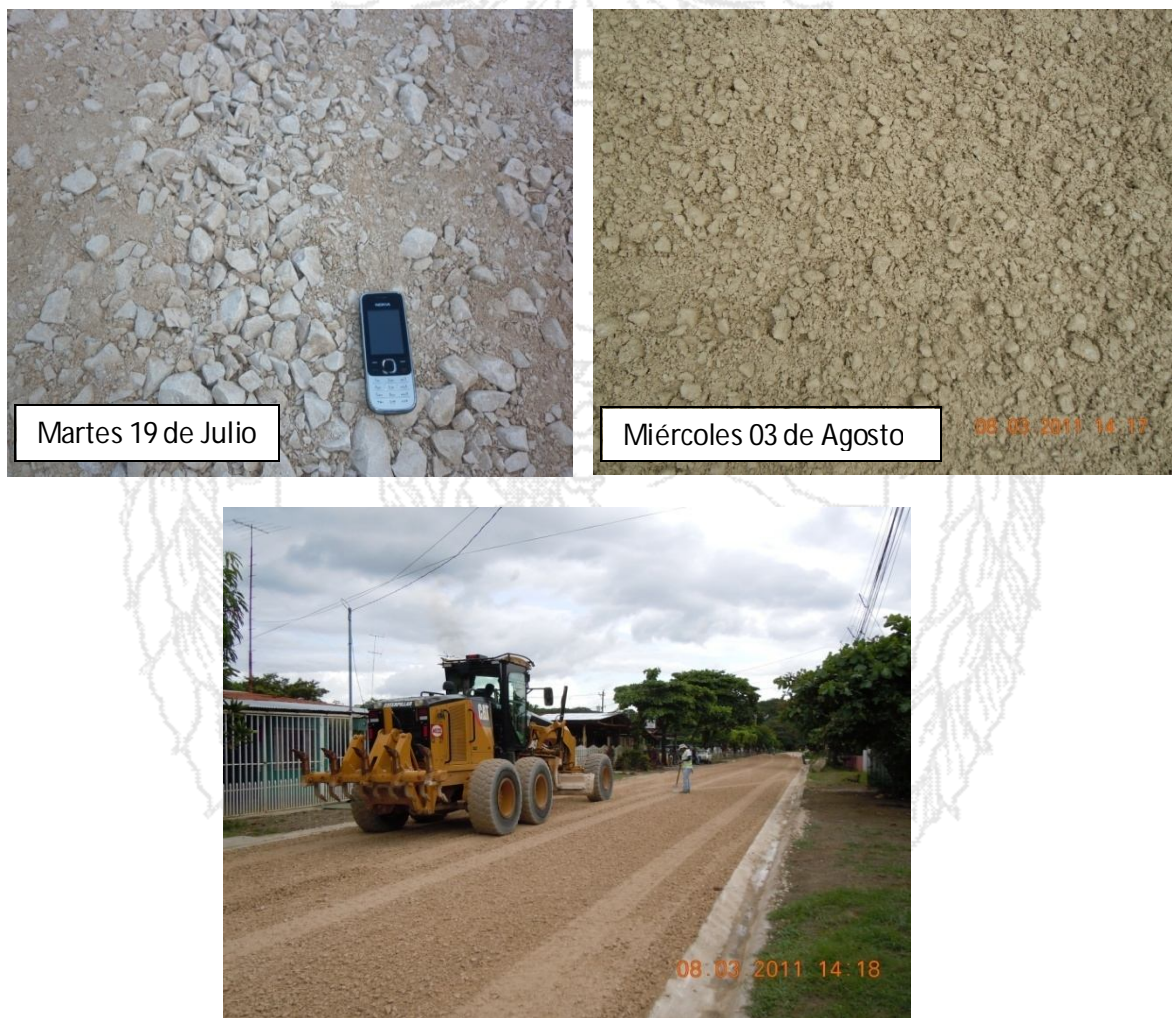
Figura 12: Mejoría en la distribución granulométrica del material de base. Proceso constructivo, conformación de base granular. Fuente: LanammeUCR, 2011.
