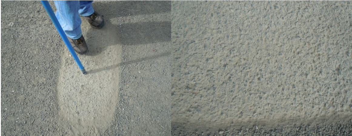
Figura 38: Material de secado no barrido, acabado de tratamiento superficial. Fuente: LanammeUCR, 2011.
