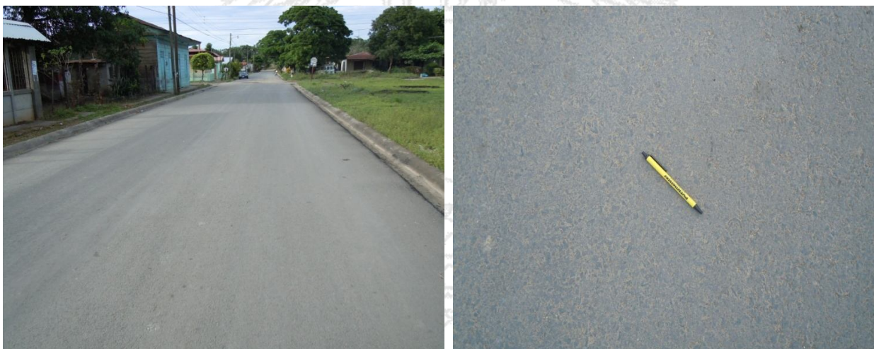
Figura 41: Condición final de los trabajos de reconstrucción en sector norte. Fuente: LanammeUCR, 2011.
