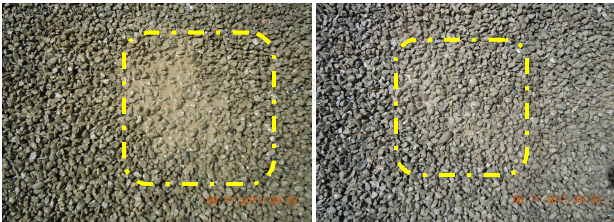
Figura 19: Contaminación de agregados con suelo. Exceso de humedad producto del lavado.
