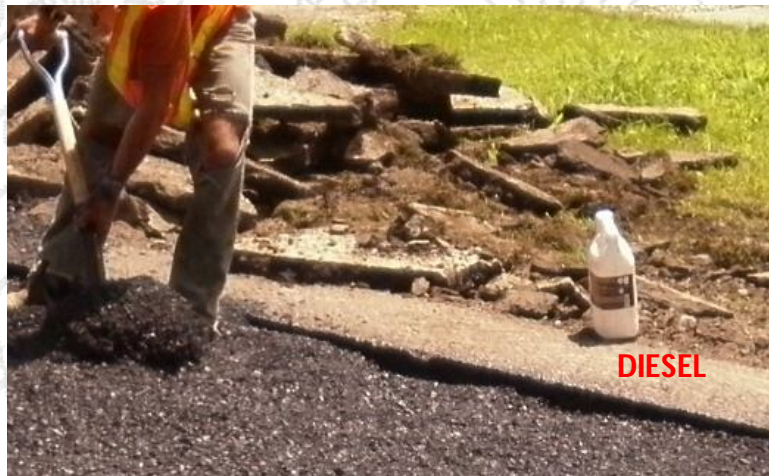
Figura 35: Utilización de diesel para limpieza de herramientas en construcción de carpetas. Fuente: LanammeUCR, 2011.
