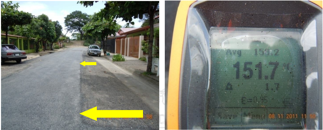
Figura 22: Cortes rectos y acabados en los bacheos. Temperatura adecuada de mezcla.
