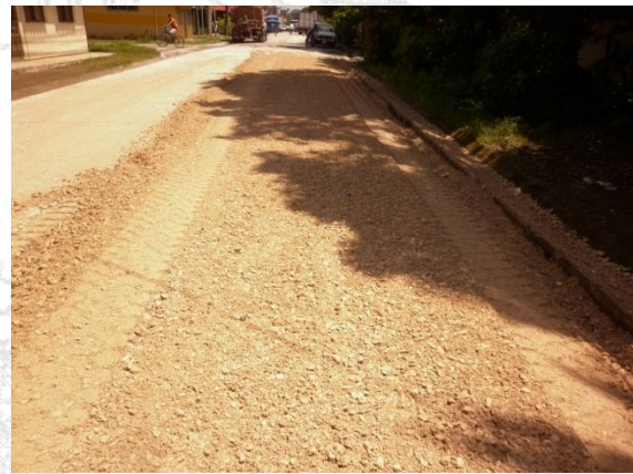
Figura 6: Estructuras existentes insuficientes. Sustitución de material de subrasante con material granular. Fuente: LanammeUCR, 2011.
