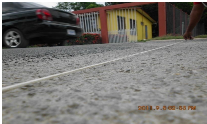
Figura 25: Verificación de los porcentajes de bombeo. Fuente: LanammeUCR, 2011.
