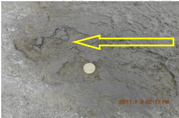
Figura 27: Desprendimientos puntuales y zonas con deficiente compactación. Fuente: LanammeUCR, 2011.
