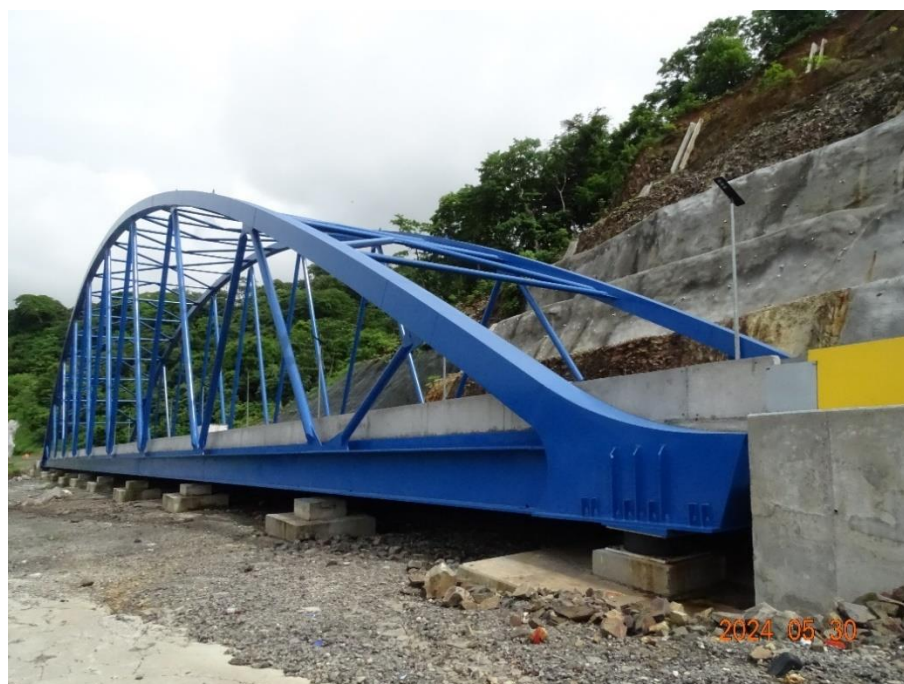
Figura 4.3. Vista lateral sur del puente hacia Caldera
