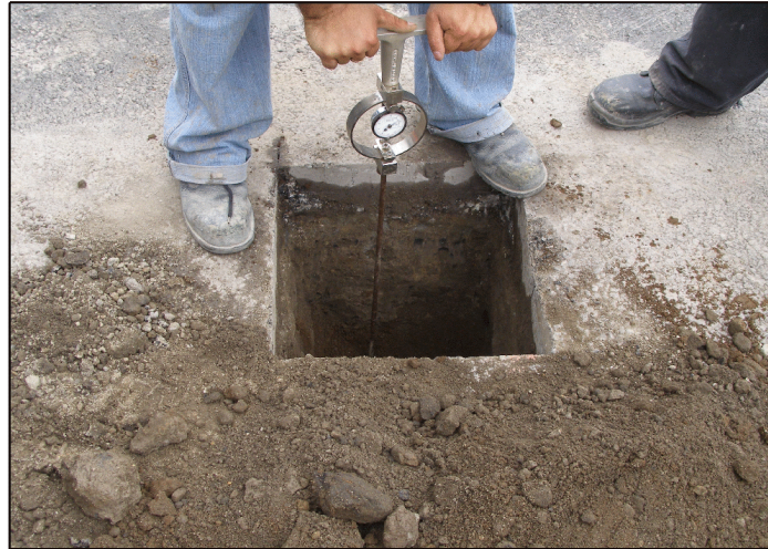
Figura 26. Prueba de CBR en sitio.
