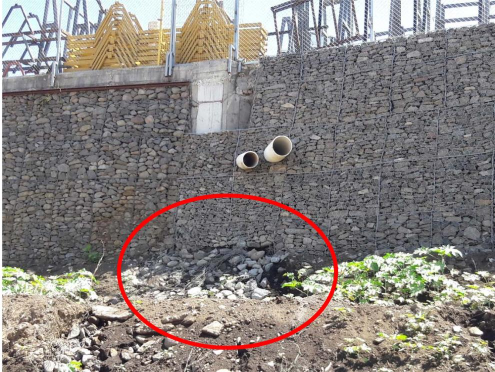
Figura 28. Deterioro observado en la parte inferior del muro de gaviones de MACOPA en el Sitio 2.
