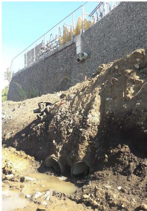
Figura 27. Presencia de estrato de suelo y desfogue de aguas próximo a la base del muro de gaviones de MACOPA en el Sitio 2.
