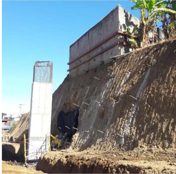
Figura 13. Talud de corte cercano a la tapia de una edificación en el Sitio 2.
