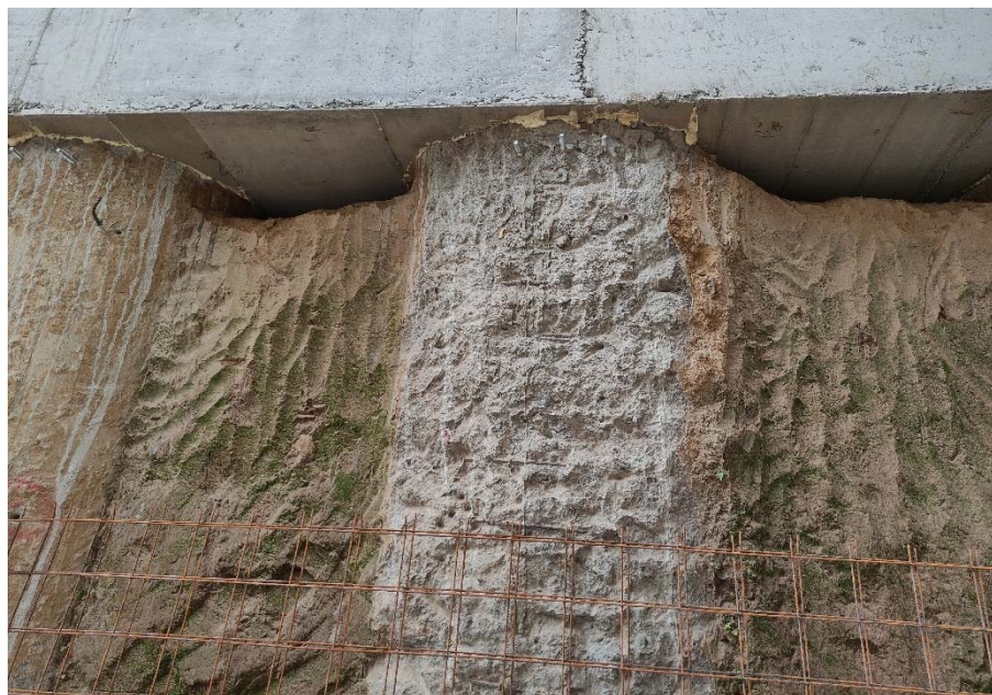
Figura 5. Colocación de malla electrosoldada y preparación de superficie para la colocación de concreto lanzado en pilotes con acero de refuerzo expuesto
