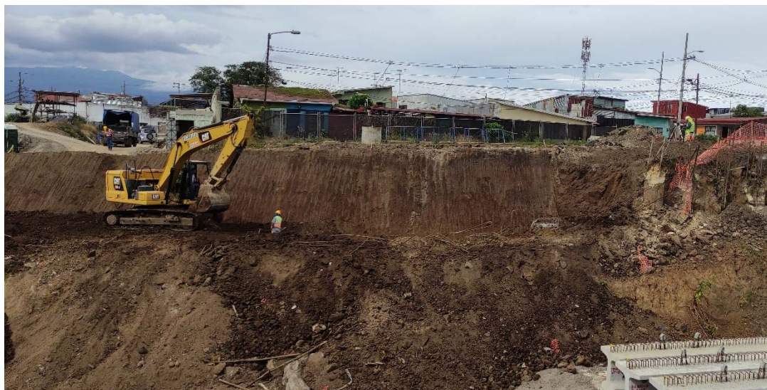
Figura 14. Cortes de terreno con coronas próximas a edificaciones y viviendas existentes
