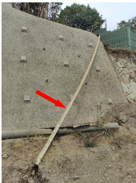
Figura 11. Medida provisional para control de aguas en la cara del talud contiguo al muro de suelo cosido en la pila 56.
