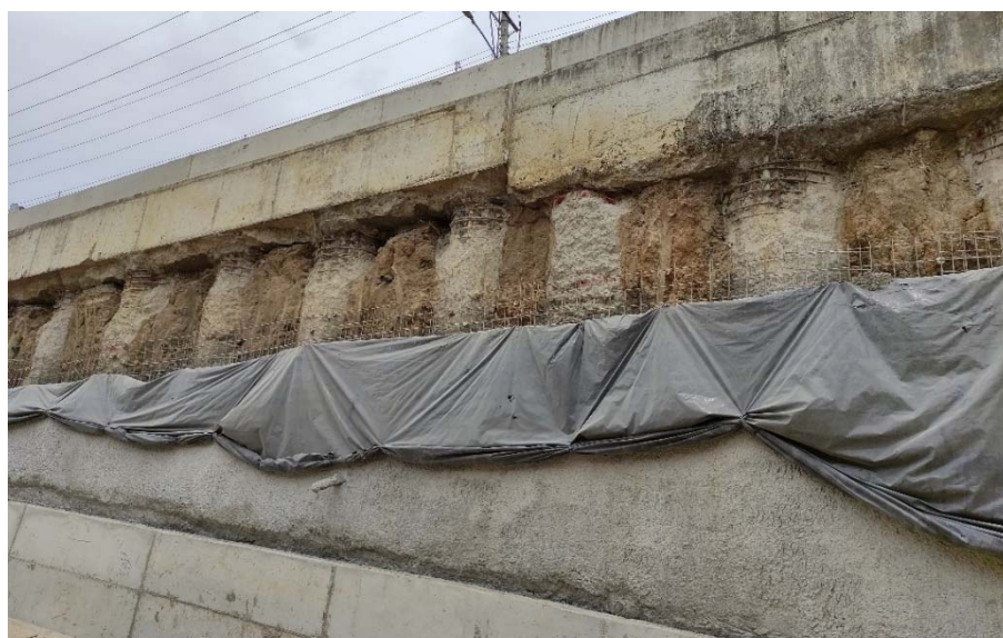
Figura 3. Pilotes sin intervenciones en el acero de refuerzo expuesto en los cuales se ha iniciado la colocación del concreto lanzado
