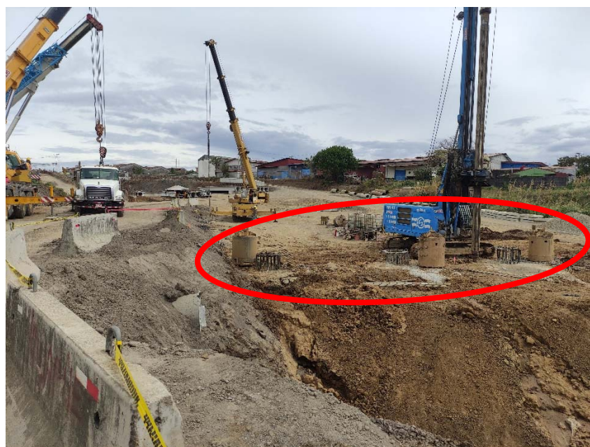
Figura 12. Pilotes construidos en el sector de MACOPA.
