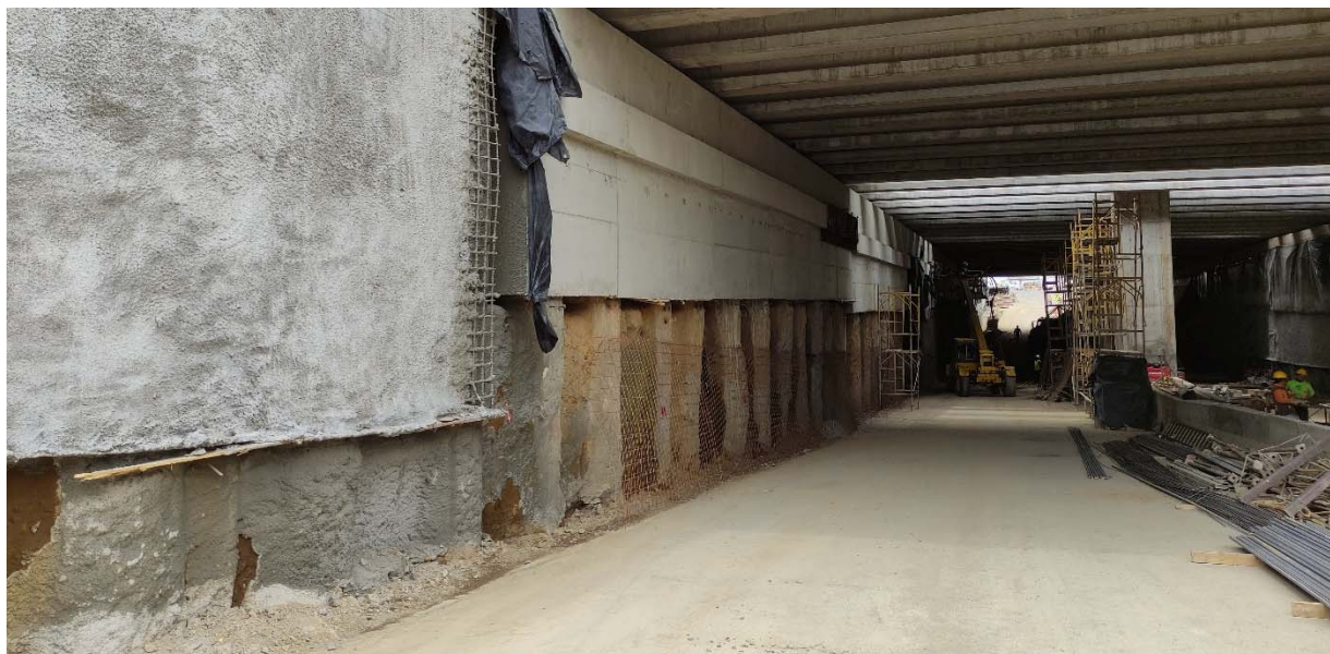
Figura 1. Avances observados en el paso deprimido en la Unidad Funcional I, Proyecto de Circunvalación Norte
