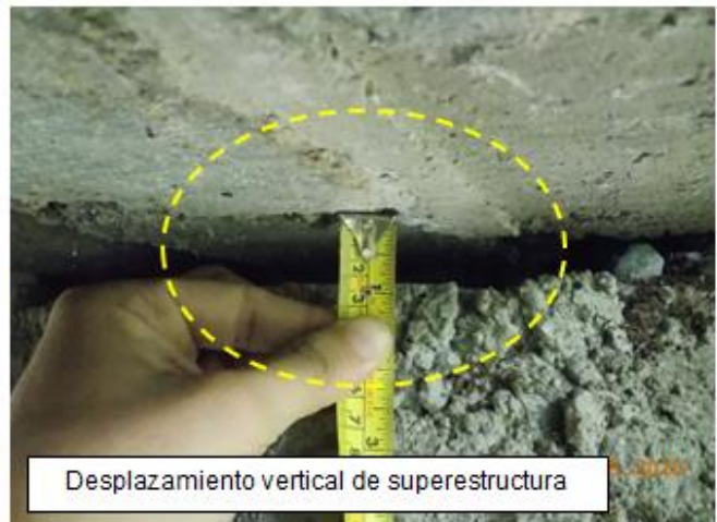
Figura 2: Desplazamiento entre superestructura y subestructura en puente Urbanización El Ingenio #2. Fuente: LanammeUCR
