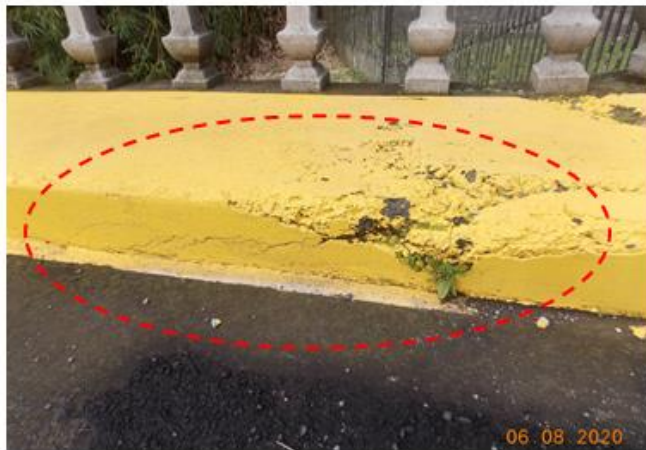
Figura 3: Daños en aceras y uniones por desplazamiento de superestructura. Fuente: LanammeUCR
