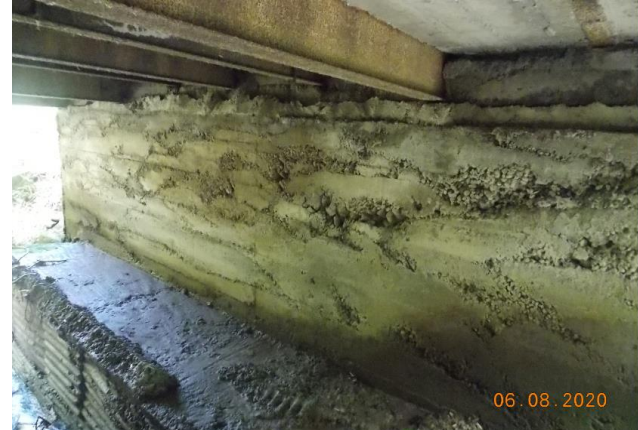
Figura 7: Inicios de corrosión en vigas principales y abundantes nidos de piedra en bastiones. Fuente: LanammeUCR
