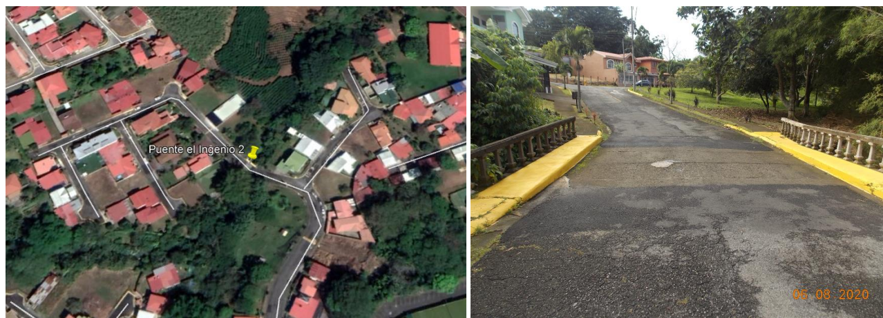
Figura 1: Ubicación del puente y vista general. Fuente: Google Earth y LanammeUCR
