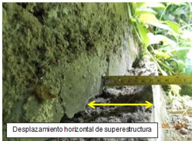
Figura 2: Desplazamiento entre superestructura y subestructura en puente Urbanización El Ingenio #2. Fuente: LanammeUCR
