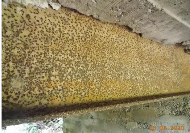
Figura 7: Inicios de corrosión en vigas principales y abundantes nidos de piedra en bastiones. Fuente: LanammeUCR
