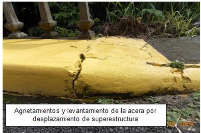
Figura 3: Daños en aceras y uniones por desplazamiento de superestructura. Fuente: LanammeUCR
