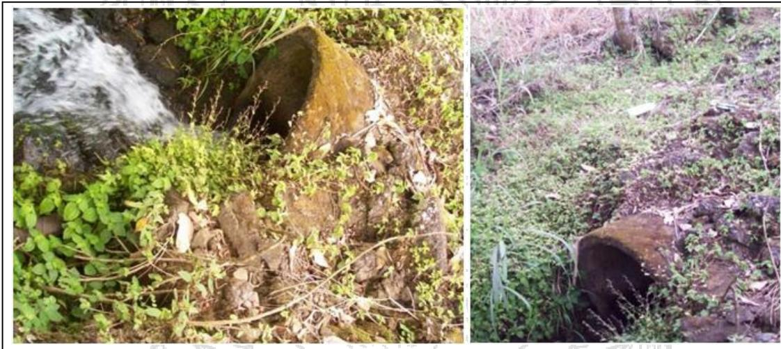
**Figura 13. Alcantarilla sin estructura de protección a la salida en Est. 42+230.**
