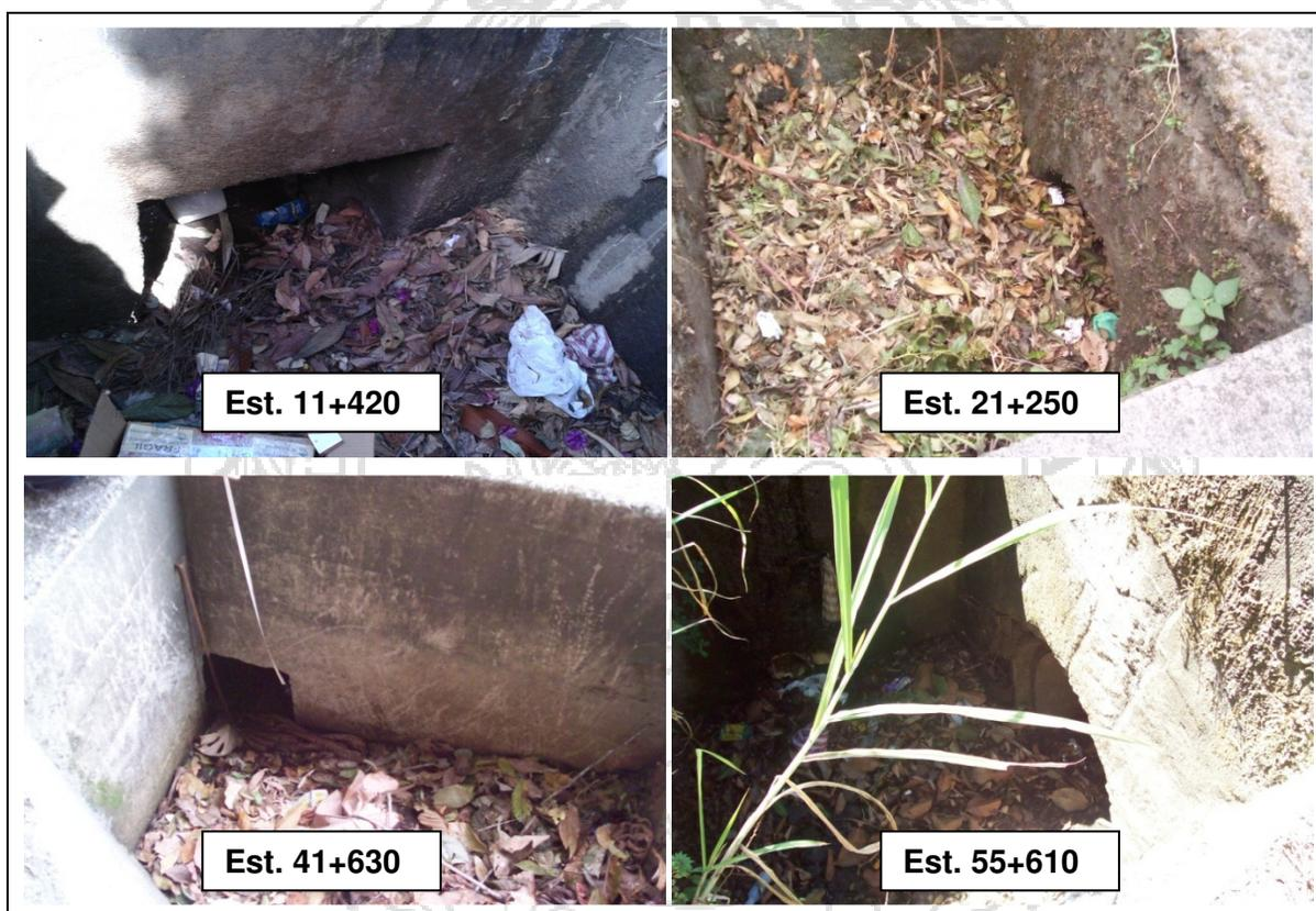
**Figura 14. Alcantarillas con sedimentos, vegetación y basura.**
