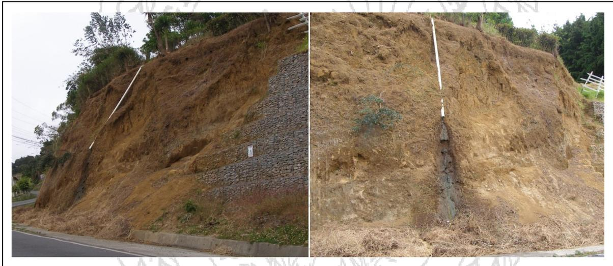
**Figura 20. Deslizamiento en estacionamiento 21+460.**
