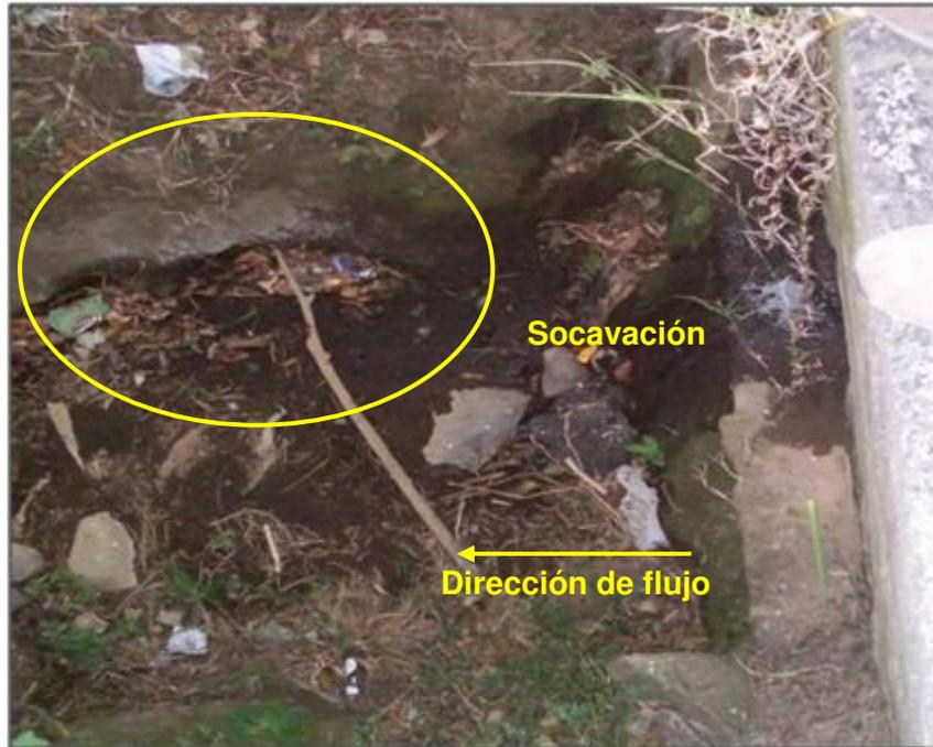
**Figura 15. Alcantarilla con socavación a la salida en Est. 21+640.**
