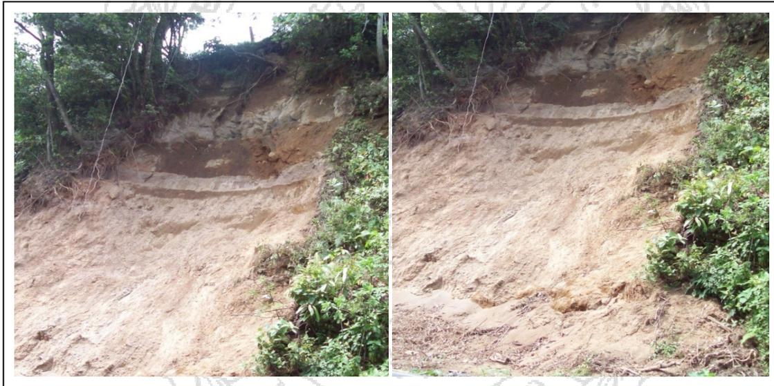
**Figura 22. Deslizamiento en estacionamiento 54+090.**
