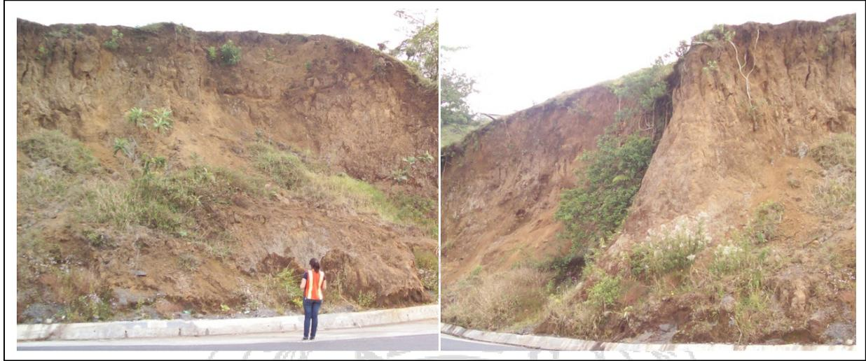
**Figura 21. Deslizamiento en estacionamiento 40+870.**
