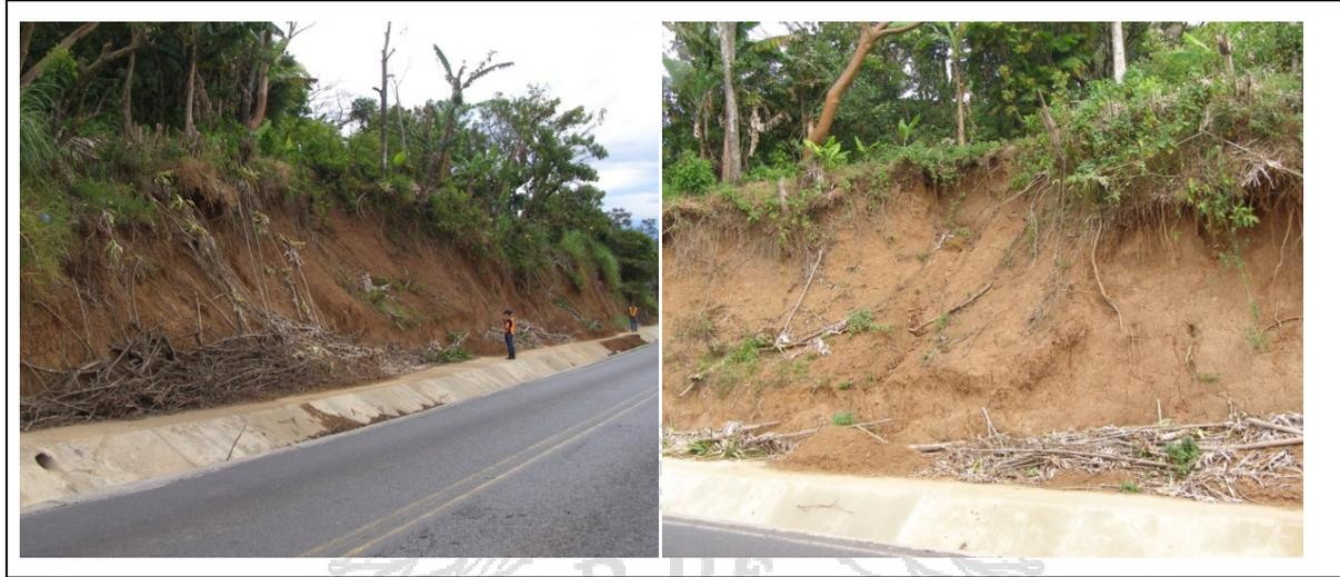
**Figura 19. Deslizamiento en estacionamiento 07+060.**
