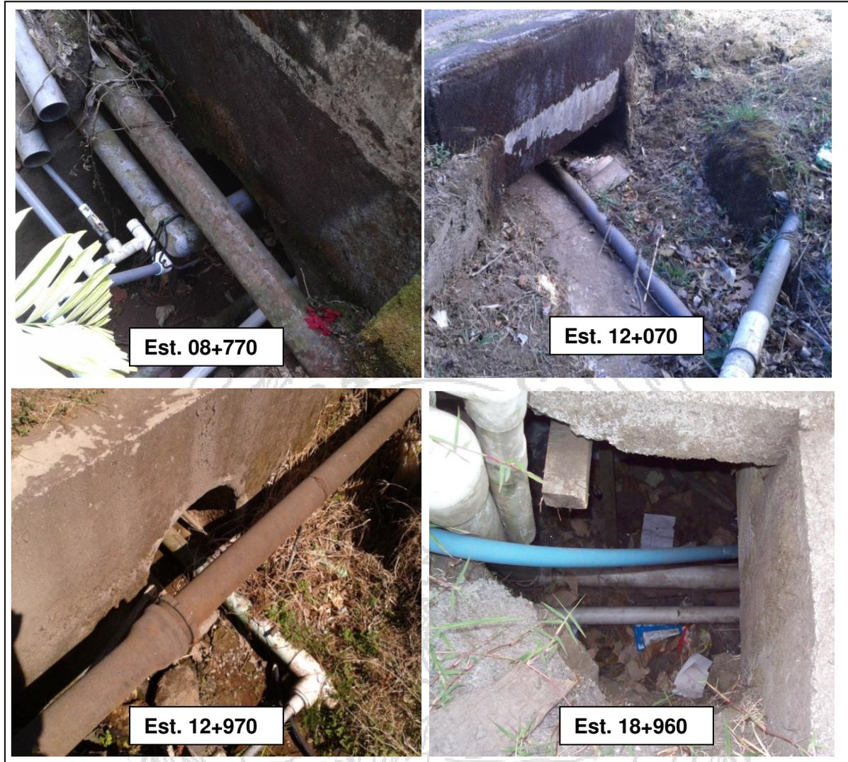
**Figura 16. Alcantarillas con tuberías que las atraviesan.**
