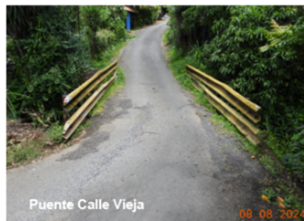
Figura 2: Vista general de los puentes Calle Sabanilla, Tacacal y Calle Vieja. Fuente: LanammeUCR
