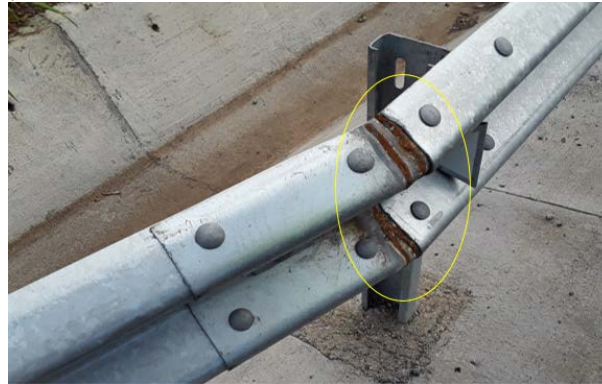
Figura 9. Ejemplo de inadecuada instalación del sistema de contención vehicular. Ruta Nacional 32, Sección de Control 40500, Estacionamiento 4+728. Fecha: 14 de diciembre de 2023.
