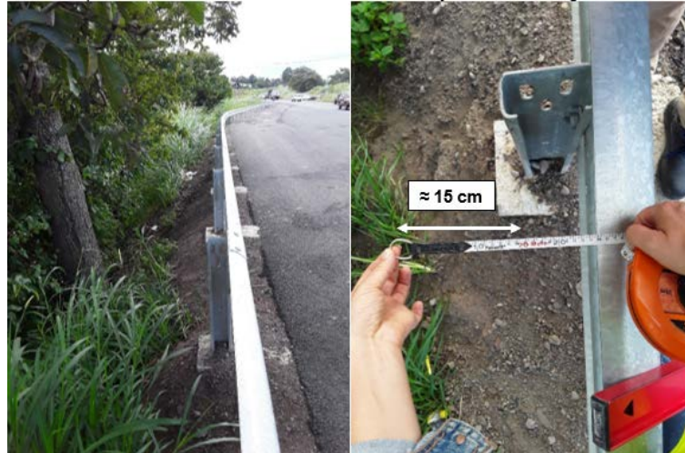
Figura 7. Distancia aproximada de 15 cm entre la barrera metálica instalada y el talud en el margen de la vía. Ruta Nacional 32, Sección de Control 40500, Estacionamiento 4+728. Fecha: 14 de diciembre de 2023.
