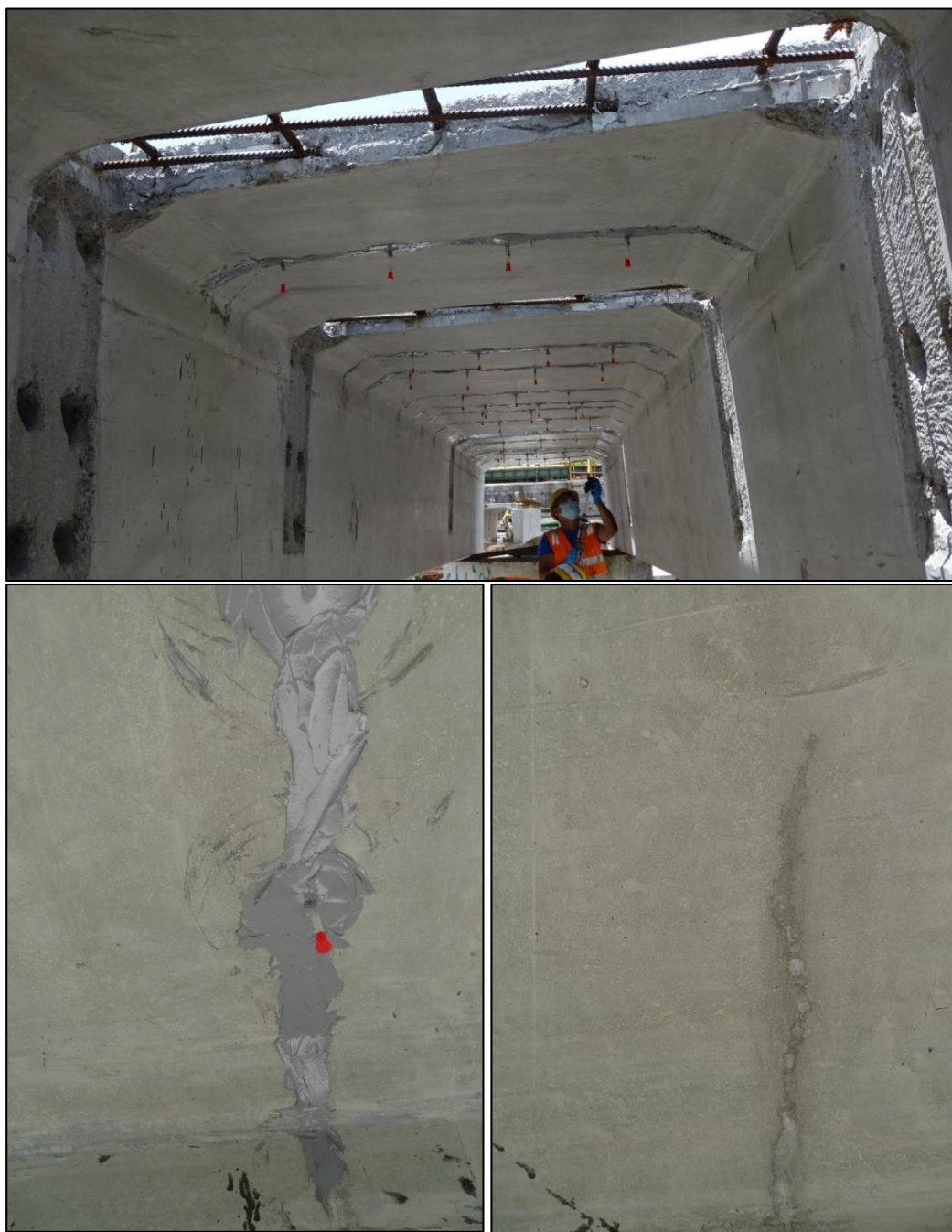
Figura 3. Muestra del sellado de grietas “sobre cabeza” mediante inyección aplicado en 32 de las 36 vigas tipo canaleta presforzada del puente.
