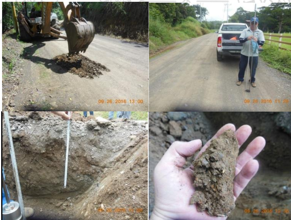
Figura 5. Excavación de sondeos a cielo abierto y ensayos DCP.
