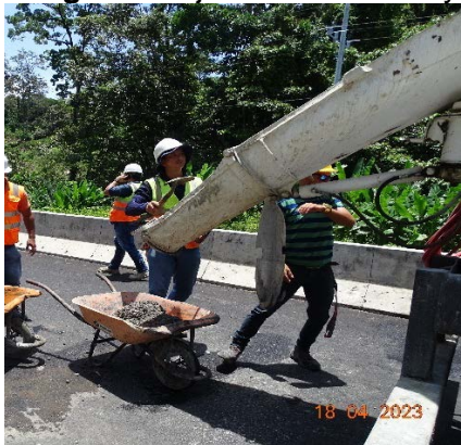
a) Ejecución del técnico A
