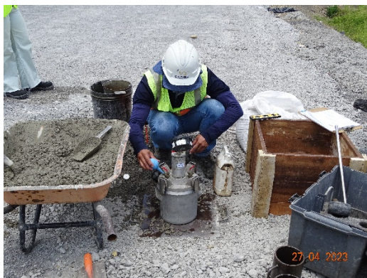
a) Ejecución del técnico A
