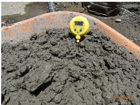
a) Ejecución del técnico A
