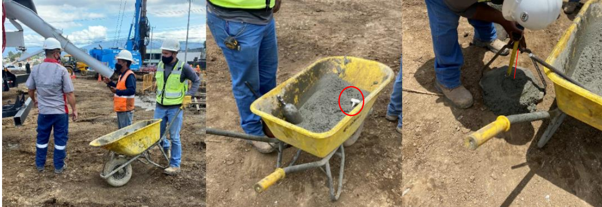
Figura 8. Pruebas de aceptación del concreto para pilotes.
