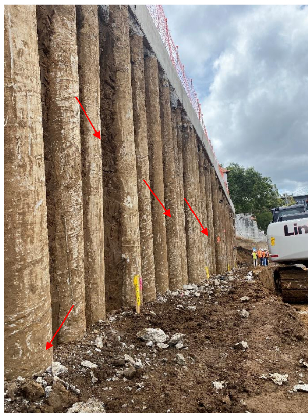
Figura 5. Alineación del muro de micro-pilotes
