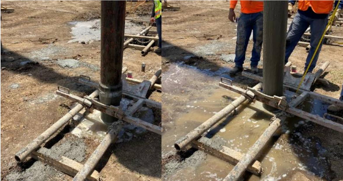
Figura 9. Colado de pilotes con tubería Tremie
