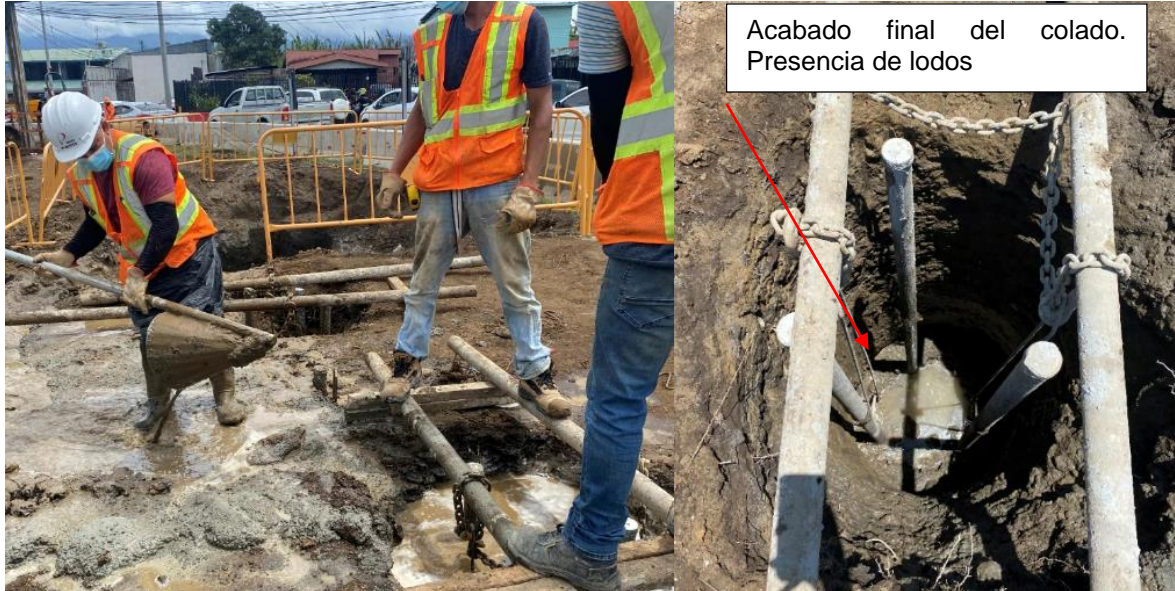
Figura 10. Procedimiento de extracción de agua y concreto contaminado en la parte superior del pilote recién colado
