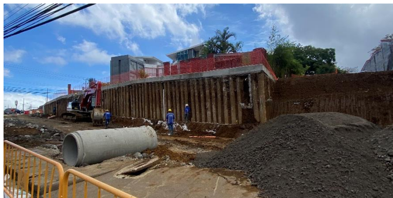
Figura 4. Nivel de excavación de muro de retención de micropilotes
