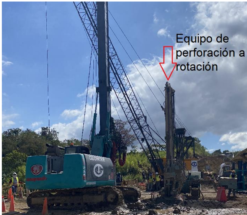
Fotografía 6. Proceso de debilitación del terreno
