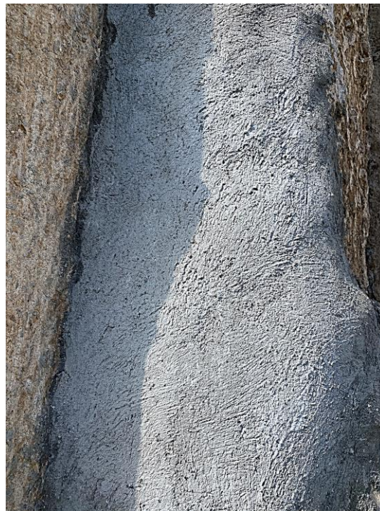
Fotografía 1. Reparación de pilote
