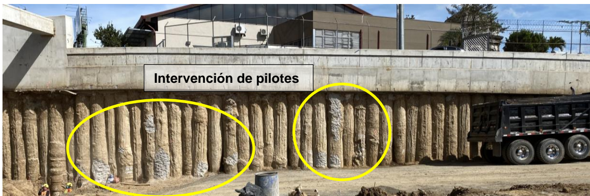
Fotografía 9. Pilotes intervenidos del Muro Sur, sentido San Pedro – Calle Blancos
