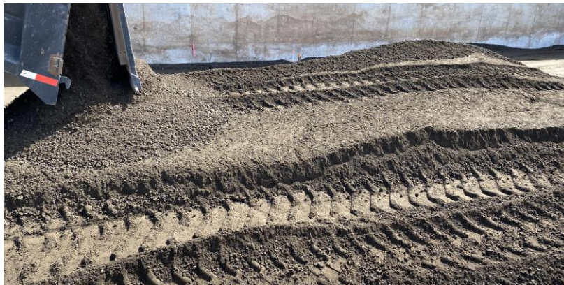
Fotografía 16. Base estabilizada con cemento
