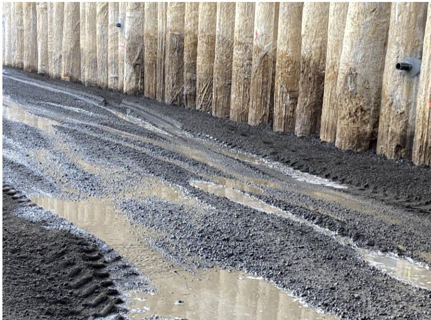
Fotografía 13. Ubicación en sitio de los drenajes en los muros de pilotes
