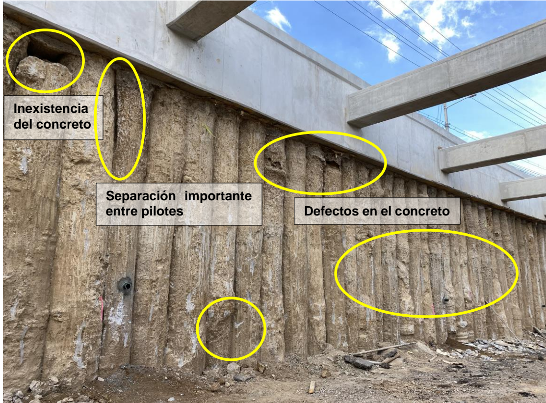
Fotografía 8. Pilotes del Muro Sur, sentido Calle Blancos – San Pedro
