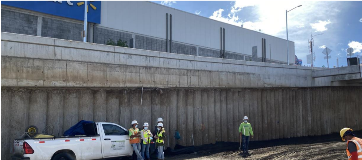
Fotografía 5. Pilotes del Muro Norte, sentido San Pedro – Calle Blancos
