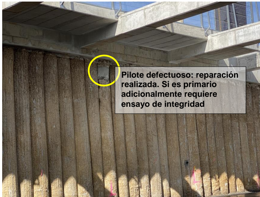
Fotografía 3. Pilote reparado en la parte superior, Muro Norte sentido Calle Blancos – San Pedro
