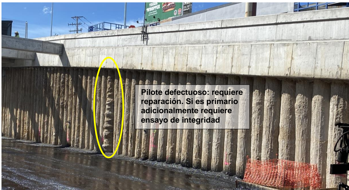
Fotografía 1. Muro de pilotes sector norte, sentido Calle Blancos – San Pedro
