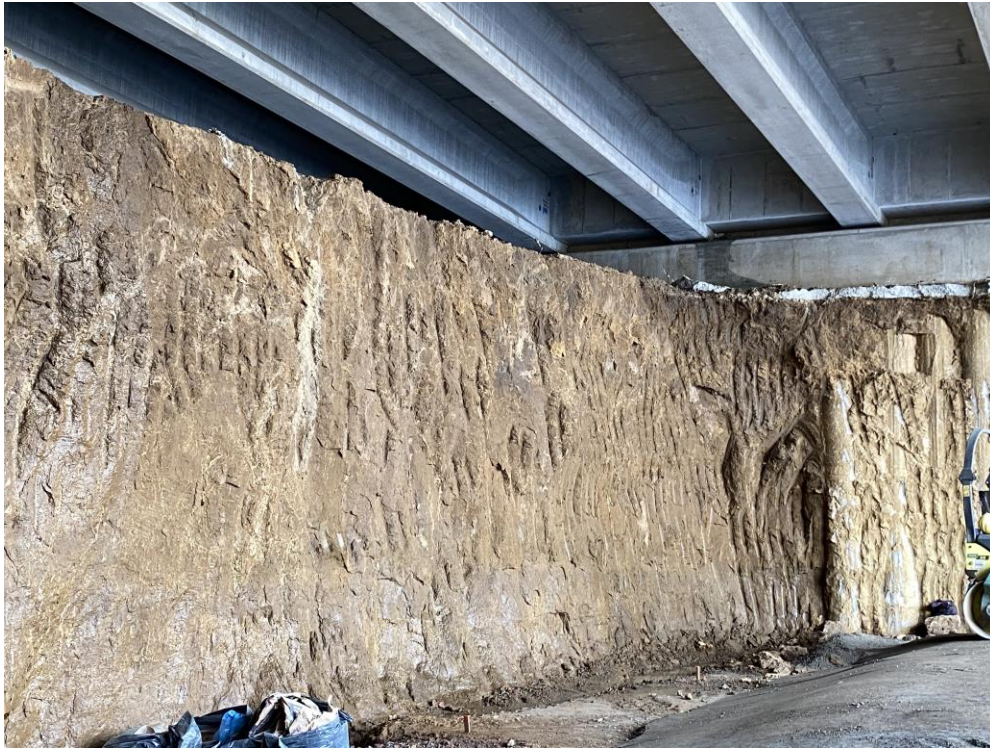
Fotografía 7. Frente de excavación, Muro Norte
