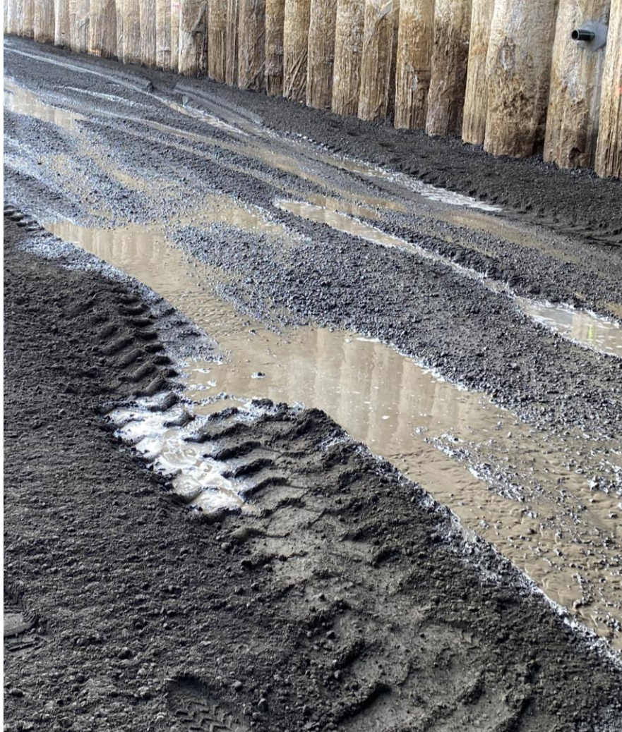
Fotografía 17. Zonas con agua empozada en base estabilizada
