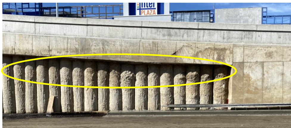
Fotografía 4. Muro Norte, sentido Calle Blancos – San Pedro
