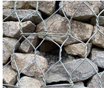
(b) Espacio vacío por desintegración de roca
