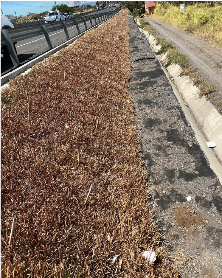
Figura 13 Vegetación como medida de protección de taludes de poca altura
