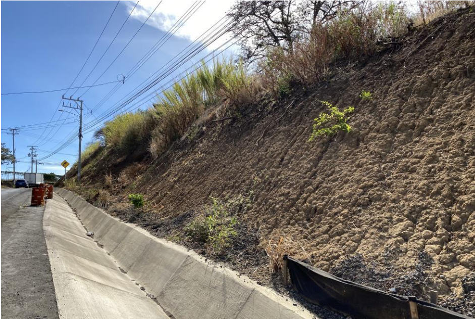
Figura 4 Taludes sin actividades de construcción de suelo cosido indicados en planos
