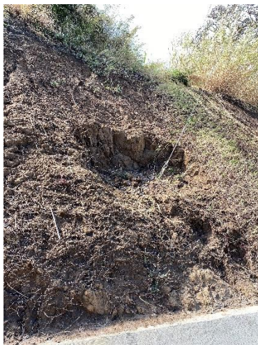
Figura 3 Problemas de inestabilidad local y material caído en zonas del talud derecho
