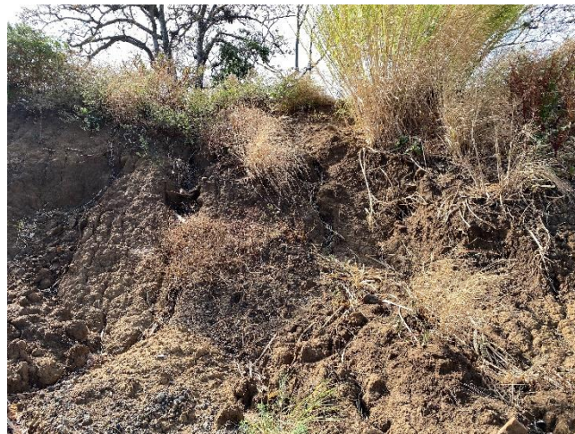
Figura 3 Problemas de inestabilidad local y material caído en zonas del talud derecho
