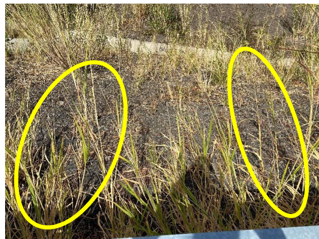
(b) Talud izquierdo
