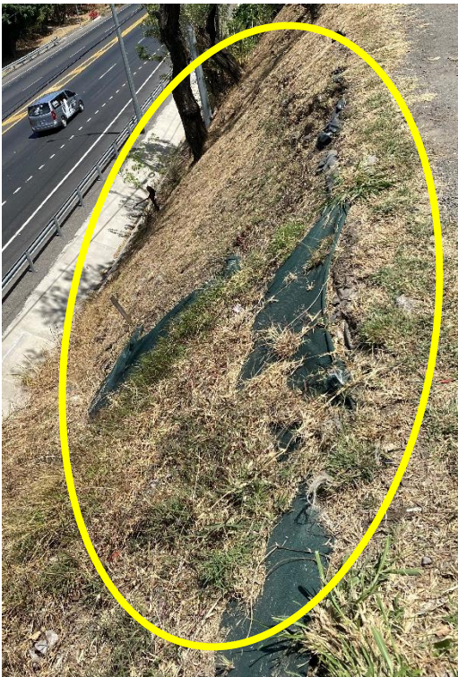
Figura 19 Algunas medidas contempladas en el talud en zona de aduanas Santamaría
