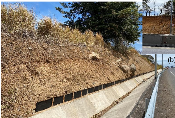
(a) Talud derecho sentido San José – San Ramón
