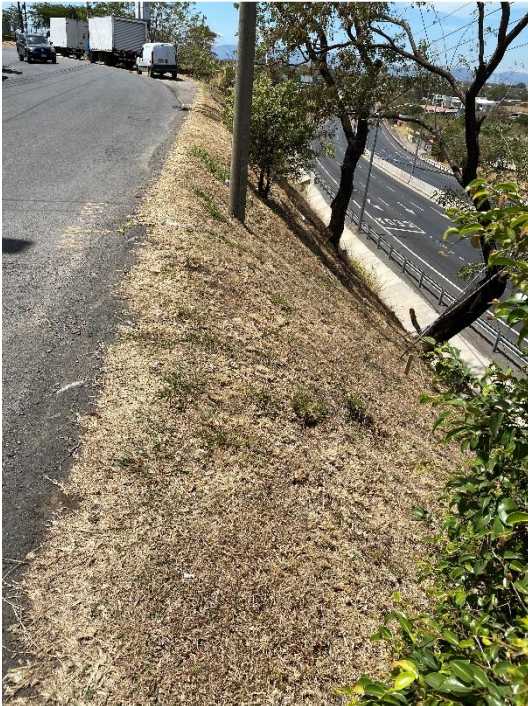
Figura 17 Parte superior del talud cercano a las terminales y aduanas Santamaría
