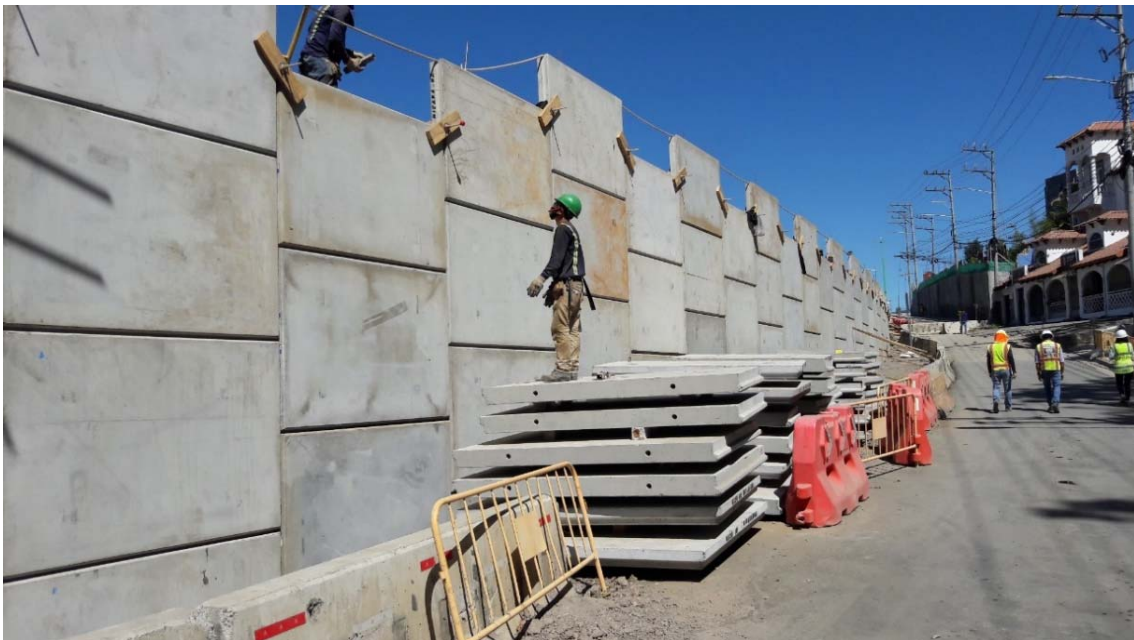
Fotografía 13. Verticalidad de muros de suelo reforzado
