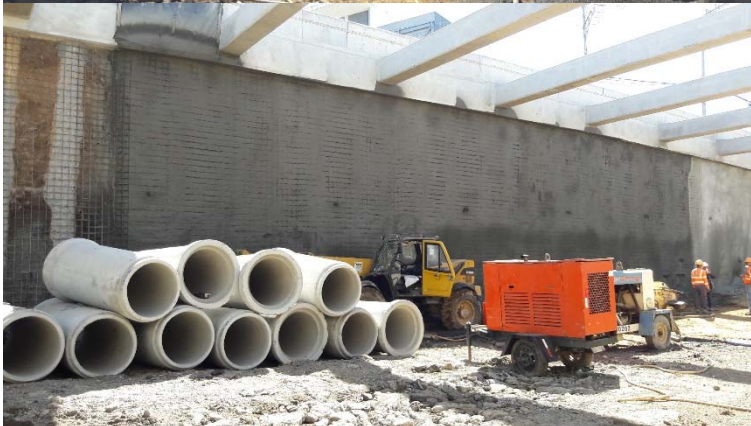
Fotografía 1. Actividades de colocación del concreto lanzado, sentido La Bandera – Guadalupe
