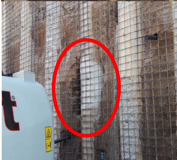
Fotografía 6. Defectos constructivos en el pilote 60D y su reparación
