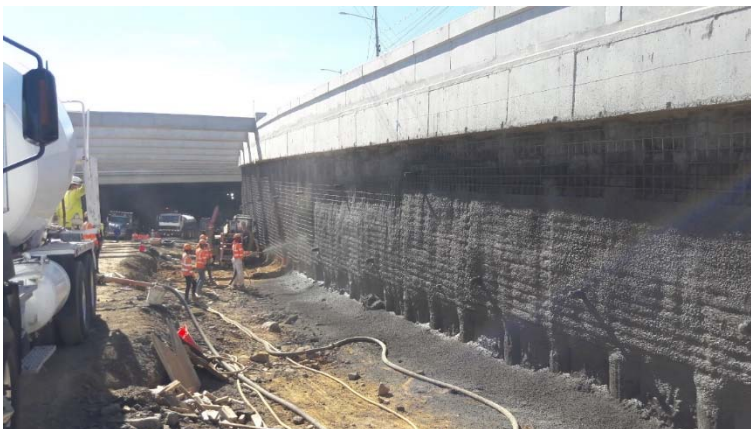
(a) Sector norte de la intersección rotonda de La Bandera, lado izquierdo (rampa de acceso a Barrio Escalante)
