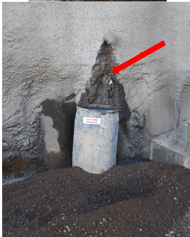
Fotografía 10. Ejemplo de colocación y funcionamiento de drenajes del muro de pilotes
