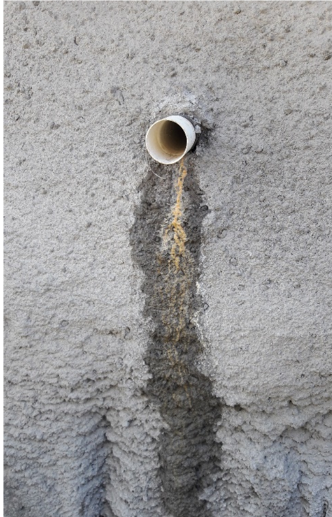
Fotografía 9. Ejemplo de colocación y funcionamiento de drenajes del muro de pilotes
