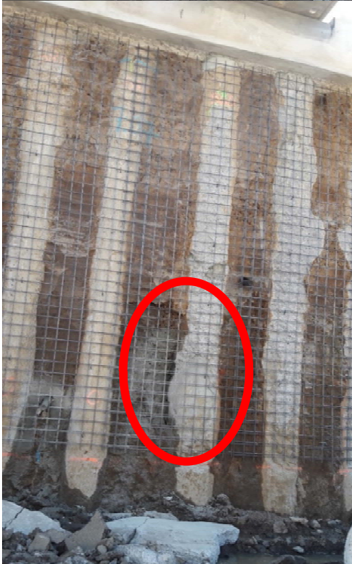
Fotografía 5. Defectos constructivos en el pilote 55D y su reparación
