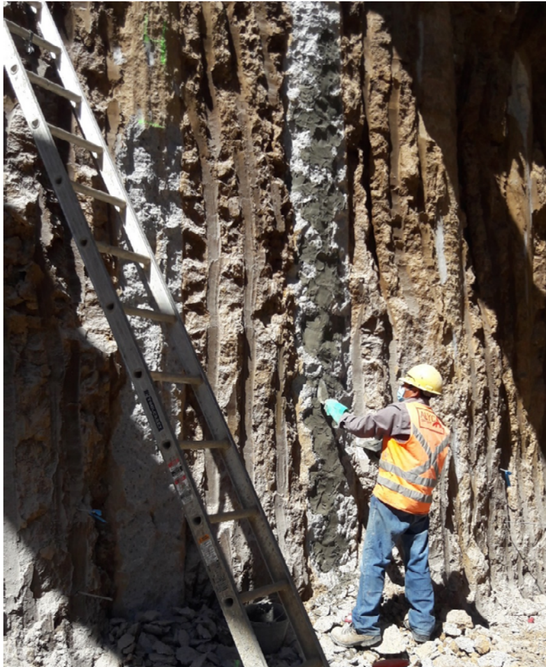
Fotografía 3. Ejemplo de intervenciones menores realizadas en el muro de pilotes
