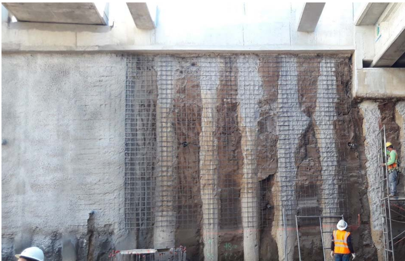
Fotografía 2. Alineamiento de pilotes del muro
