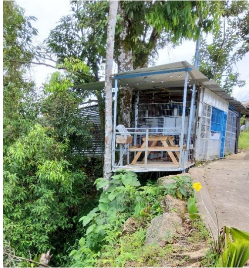
Figura 3 Vivienda ubicada en la corona del talud
