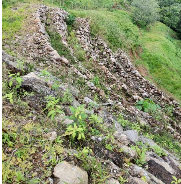
Figura 2 Estructura de contención tipo muro de enrocado por gravedad
