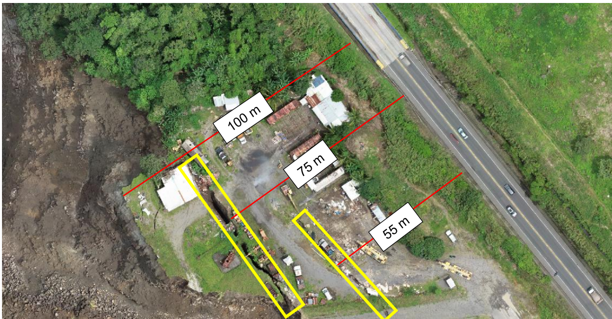
Figura 1 Condición del sitio afectado por el deslizamiento de la margen del río Virilla en el km 17+065 de la RN 27
