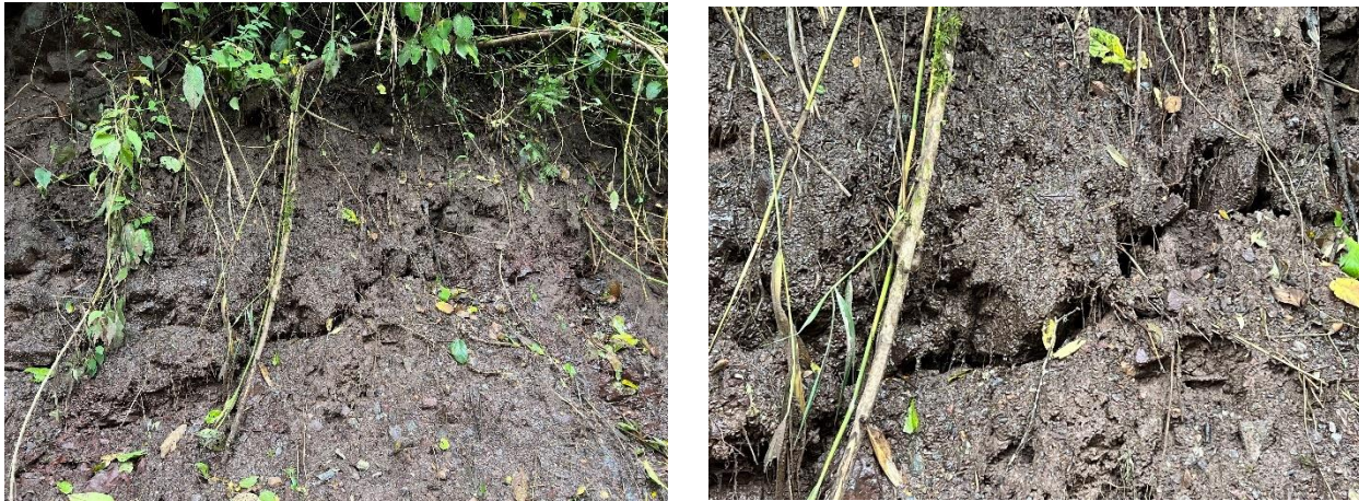
Figura 5 Conformación del material en el talud aledaño al deslizamiento
