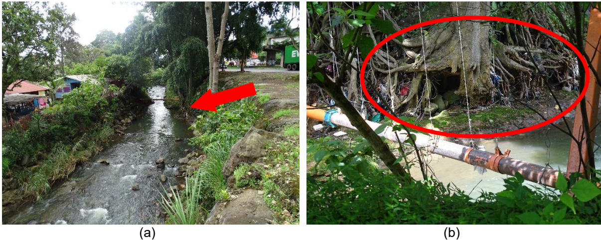
Figura 6. Condición de las raíces de árboles próximos a los márgenes del cauce del río María Aguilar
