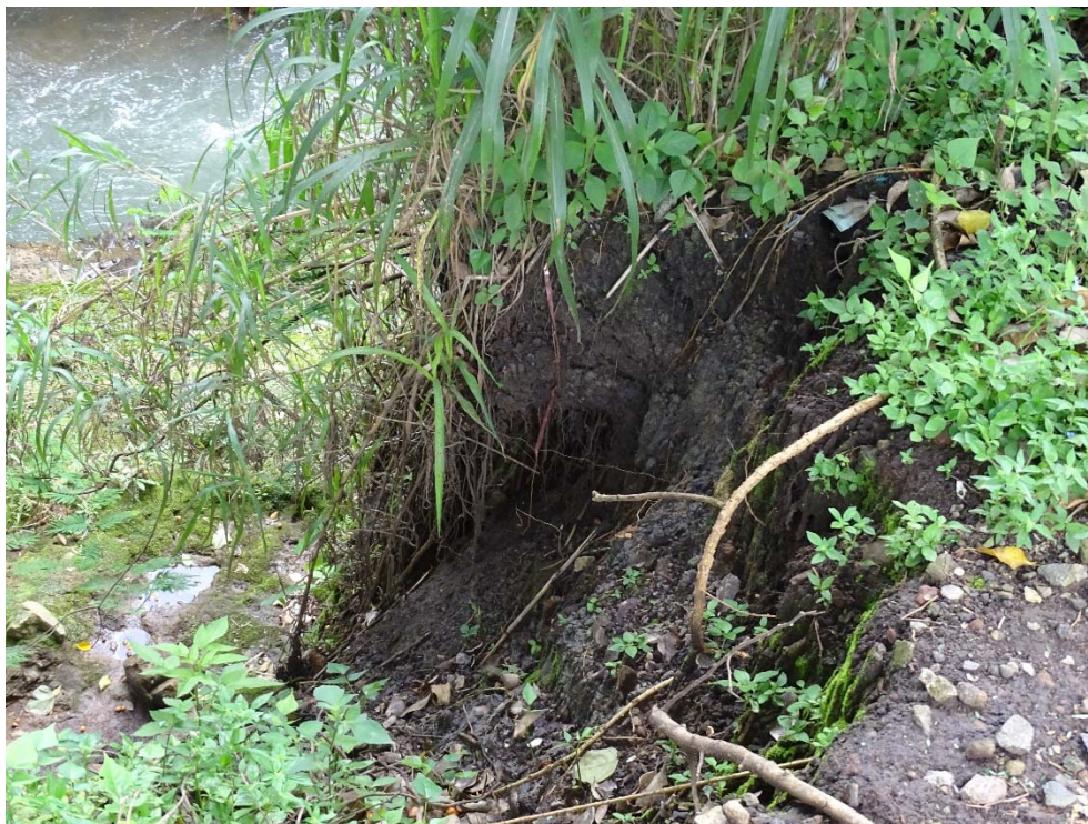
Figura 5. Problemas de estabilidad del talud en la margen izquierda del cauce del río María Aguilar
