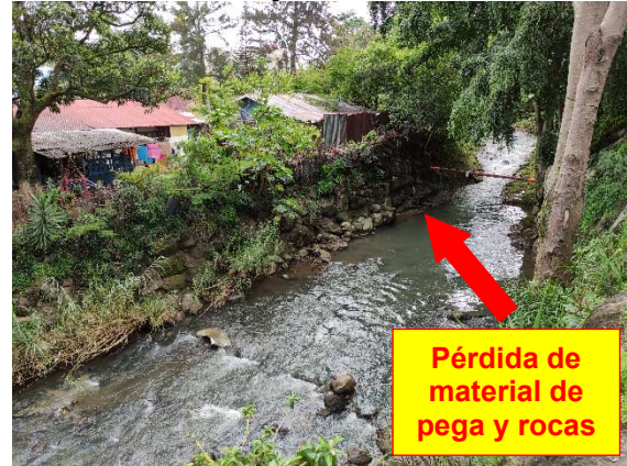
Figura 1. Comparación de la condición de las obras de reforzamiento de las márgenes del río María Aguilar entre el año 2018 y 2022.
