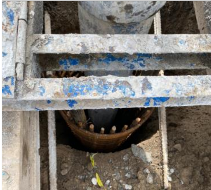
Figura 2. Armadura pilote N°27
