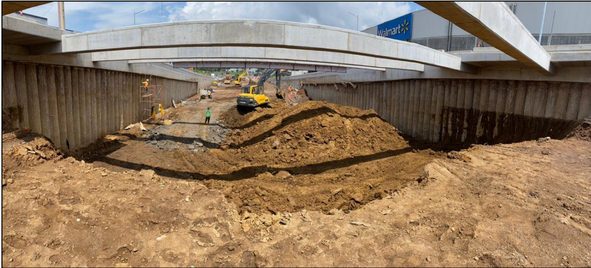
Figura 6. Muro de retención de pilotes preexcavados
