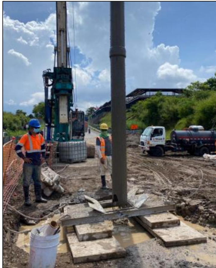
Figura 3. Finalización del colado de concreto del pilote
