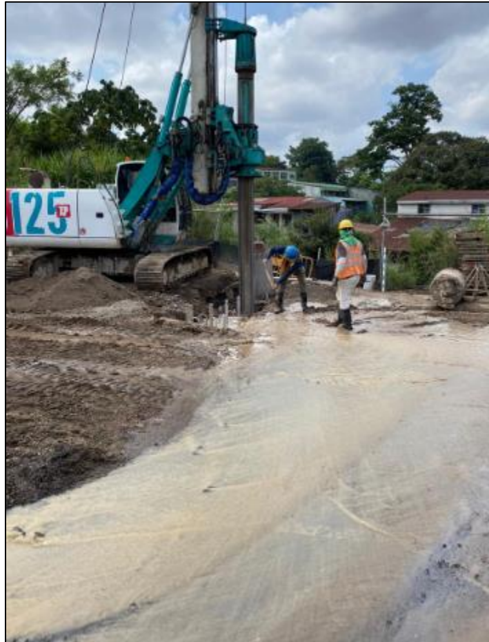
Figura 4. Flujo de agua acumulada en la perforación
