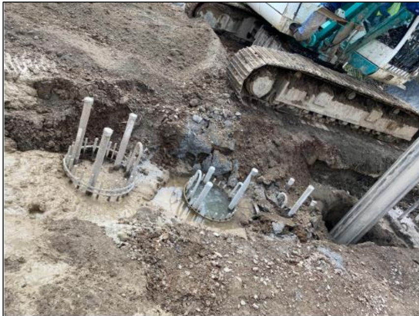
Figura 1. Pilotes del muro del puente sobre el río Torres
