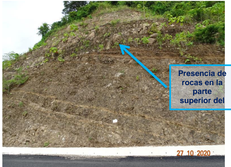
Figura 5. Talud derecho, estación 16+565
