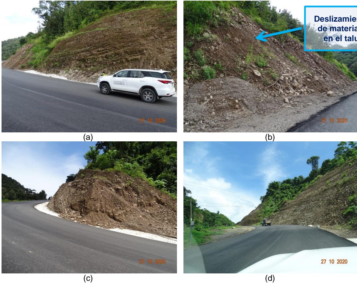
Figura 6. Tramo comprendido entre la estación 13+100 – 13+400, taludes izquierdos
