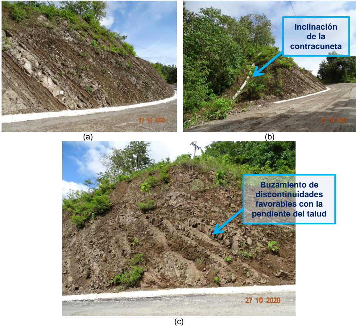
Figura 4. Talud derecho, estación 17+374
