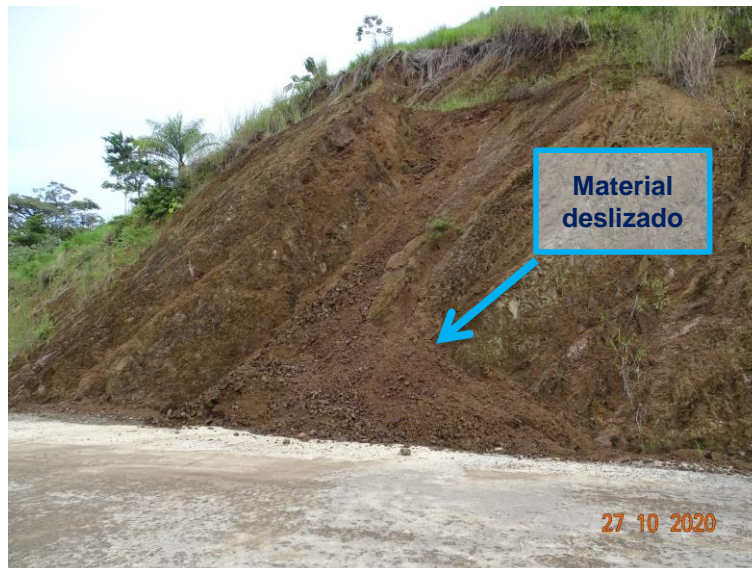
Figura 1. Talud derecho, estación 19+440
