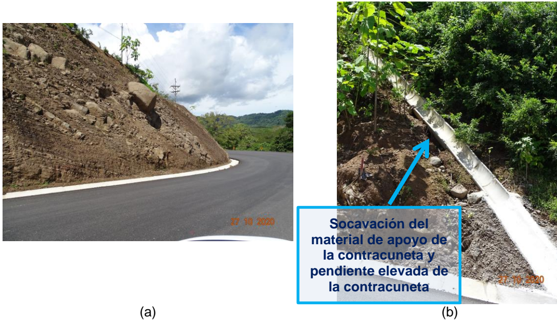
Figura 9. Talud derecho, estación 11+880
