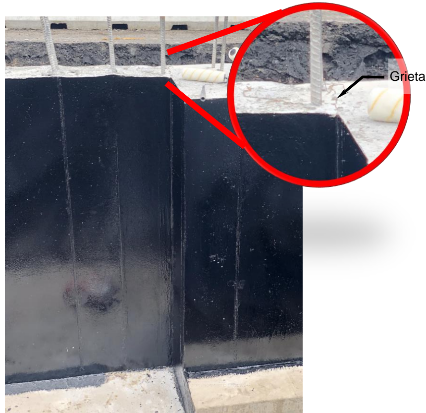
Fotografía 6. Muro de concreto reforzado con cambio de espesor
