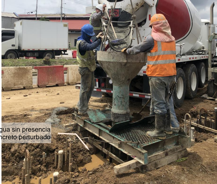
Fotografía 4. Finalización del colado de concreto del pilote
