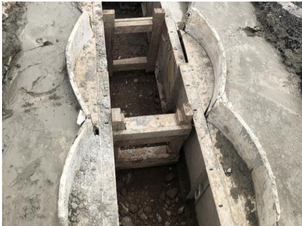
Fotografía 1. Muro guía en pantalla de pilotes
