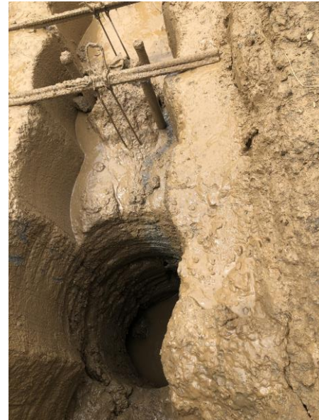
Fotografía 2. Separación entre pilotes
