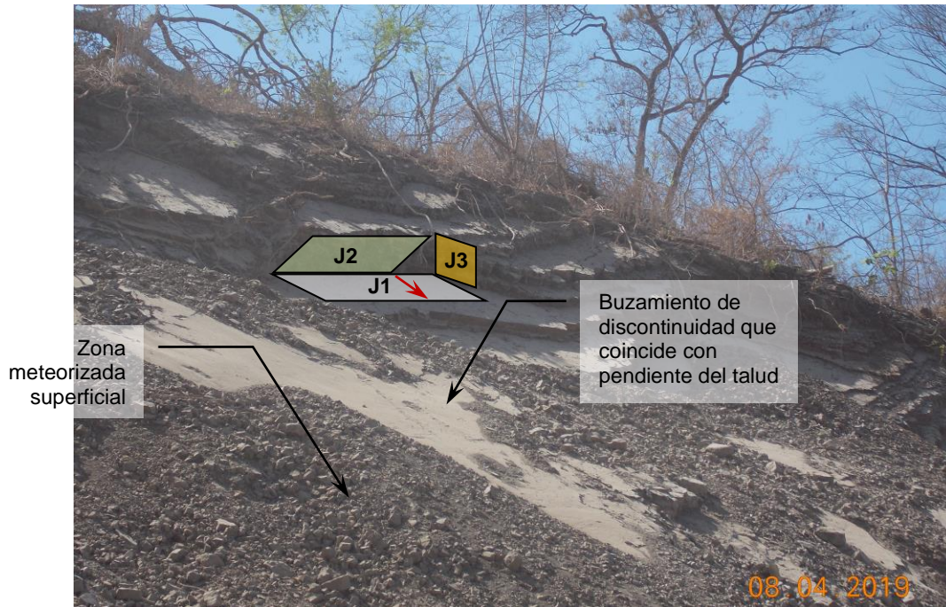
Figura 6. Talud derecho, estación 3+286
