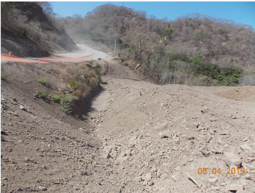
Figura 14. Estado de algunas escombreras del proyecto
