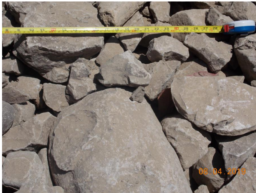
Figura 12. Relleno colocado con bloques de aproximadamente 200 mm
