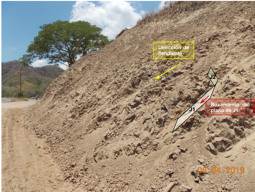
Figura 1. Talud derecho, estación 19+440
