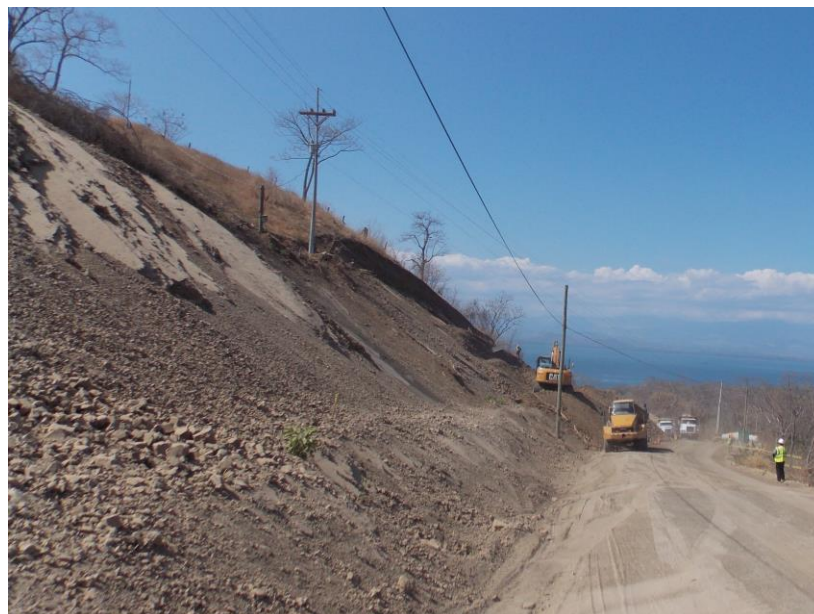
Figura 7. Vista ampliada del talud derecho, estación 3+286
