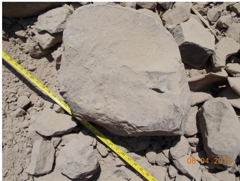
Figura 13. Relleno colocado con bloques mayores a 300 mm
