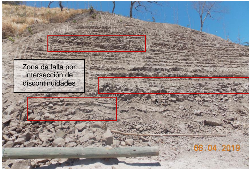
Figura 3. Talud derecho, estación 13+397
