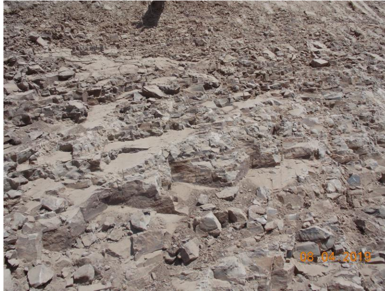
Figura 5. Materiales que conforman ambos taludes
