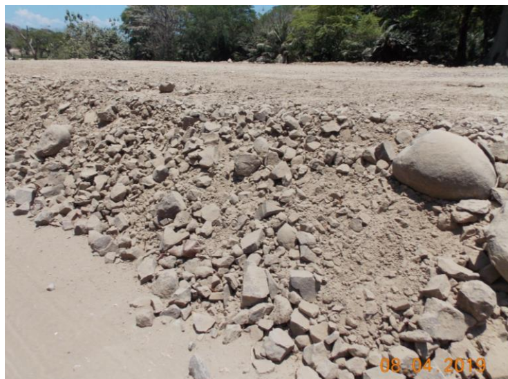
Figura 11. Relleno colocado con material considerado de sobretamaño
