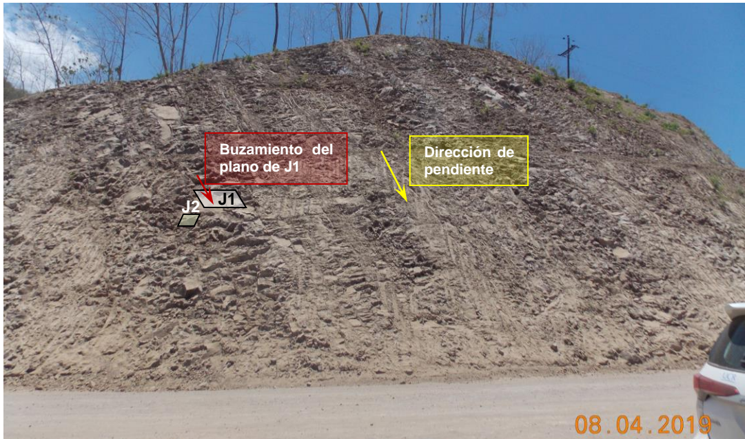
Figura 2. Talud derecho, estación 17+360
