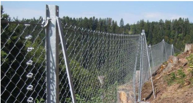
Figura 4. Barrera flexible para deslizamientos
