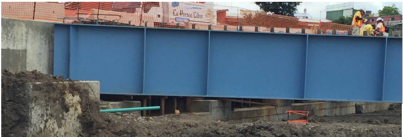
Fotografía 5. Colocación de los puentes metálicos
