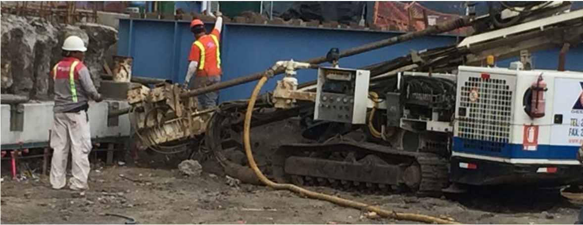
Fotografía 4. Perforación de anclaje a la viga de arriostre
