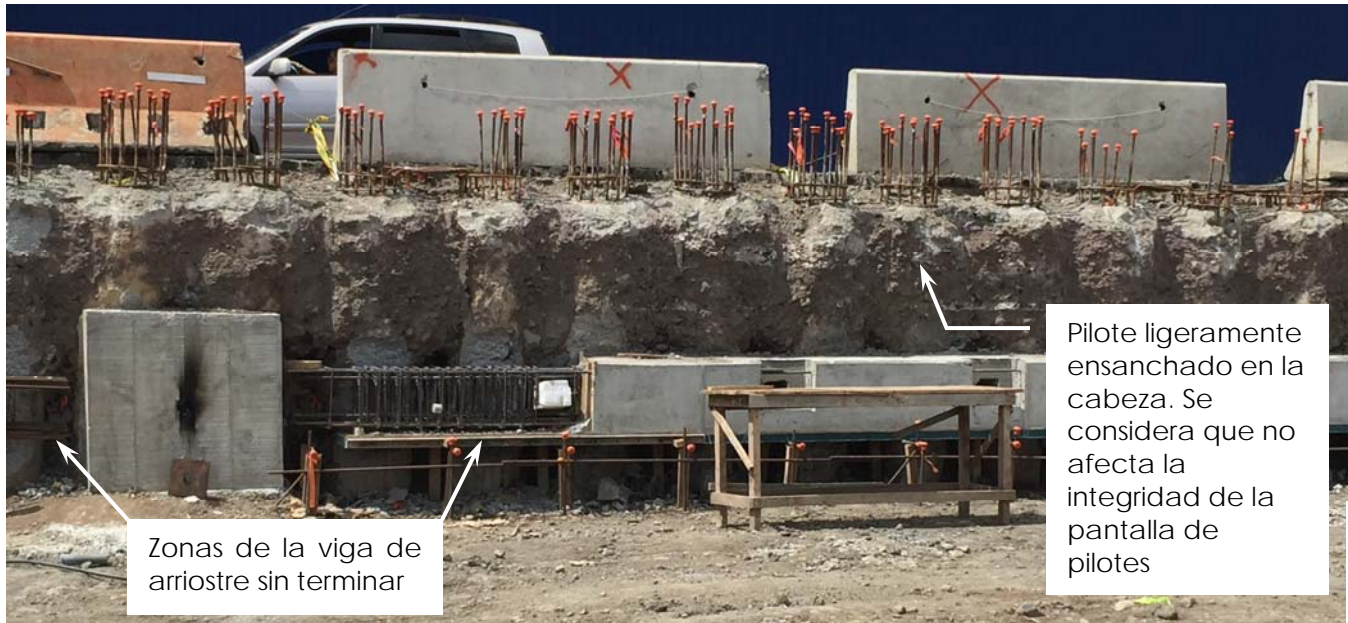
Fotografía 2. Pantalla de pilotes
