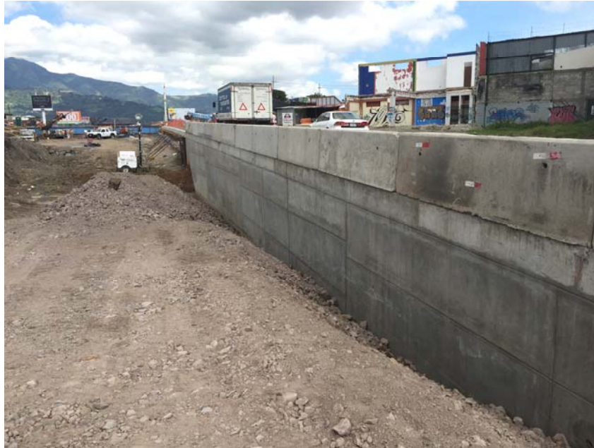
Fotografía 1. Material colocado en rampa del proyecto
