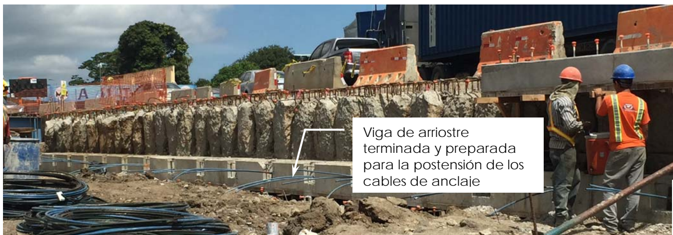
Fotografía 3. Pantalla de pilotes contigua a la de la Fotografía 2
