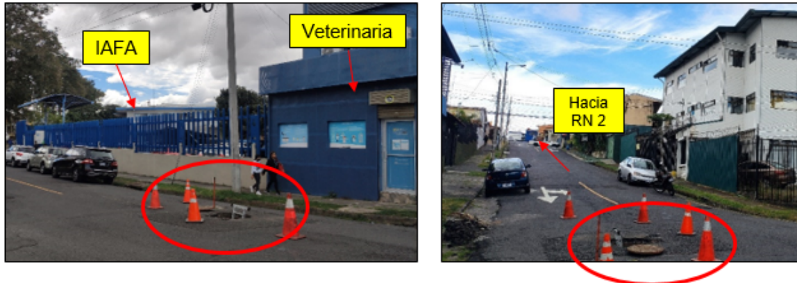
Figura 1. Ubicación del pozo de inspección IAFAP047.
