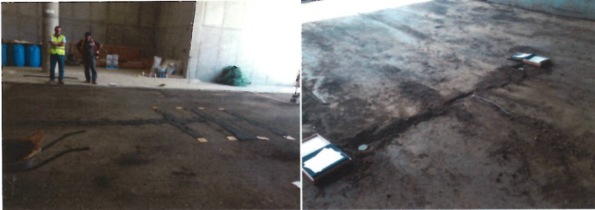
Figura 26. Instalación en sitio de instrumentación
