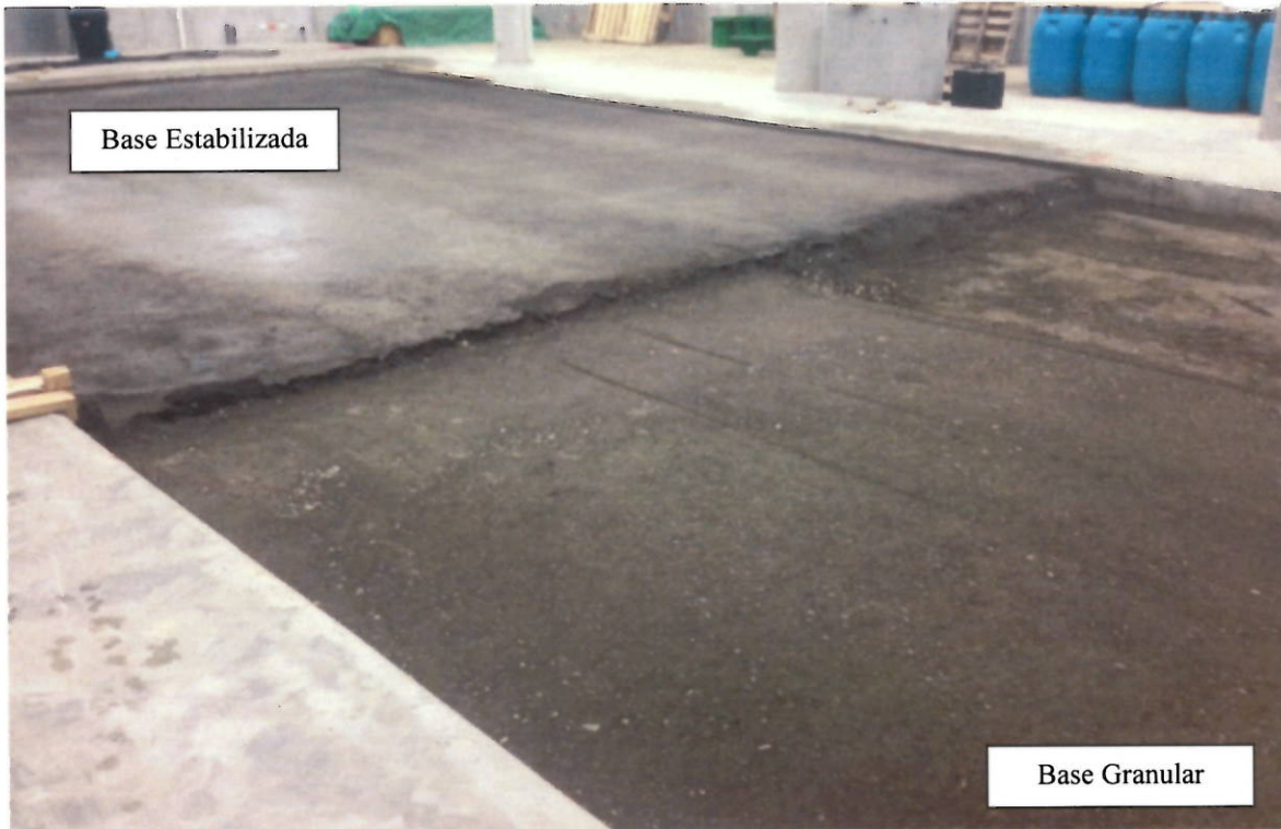
Figura 24. Construcción de capas de base
