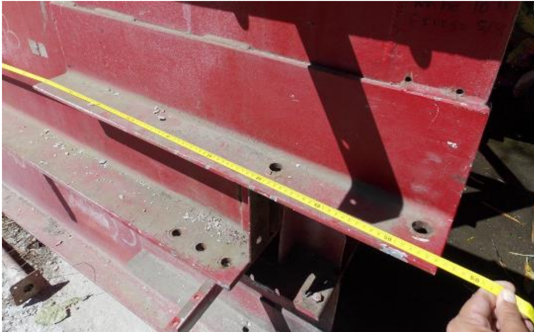
Figura 10: Medición de la longitud de las vigas del puente (18,56 m). Fuente: LanammeUCR
