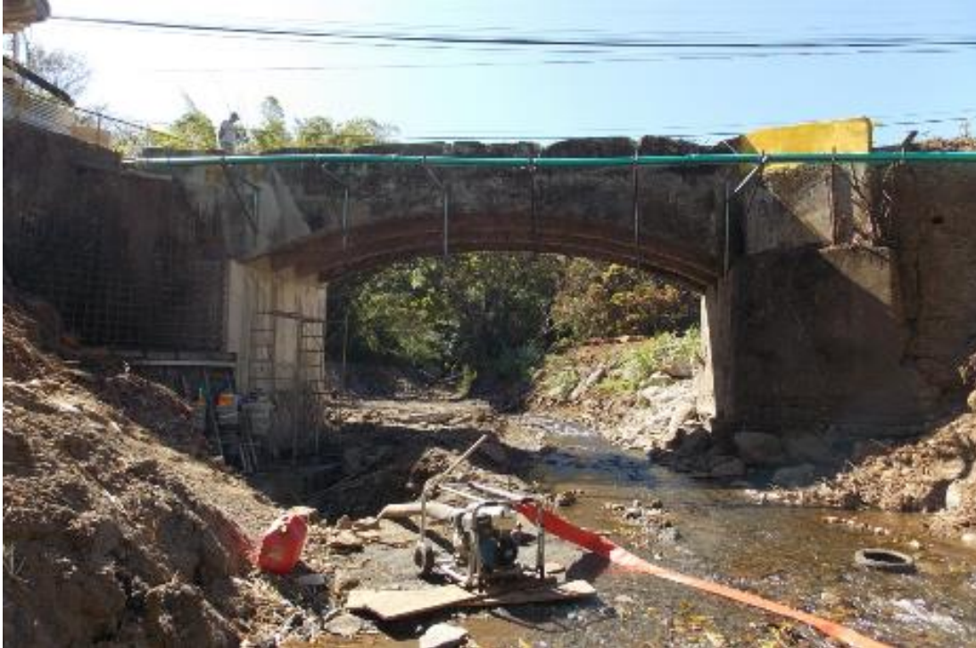
Figura 2: Vista general del puente 2 febrero 2023 Fuente: LanammeUCR
