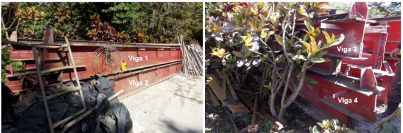
Figura 9: Identificación de las vigas adquiridas para la rehabilitación del puente sobre el Rio Cacao.
