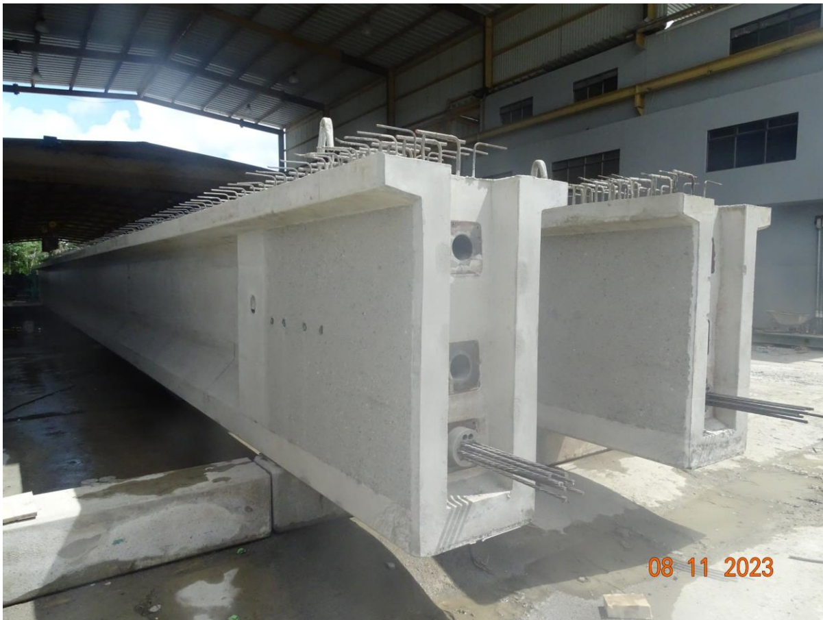
Figura 14. Vigas de superestructura n.º 5 con la superficie seca
