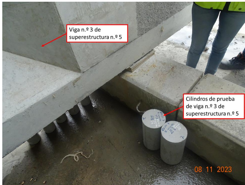
Figura 12. Cilindros de prueba colocados a un costado de la viga a la que representan (viga n.º 3 de superestructura n.º 5)
