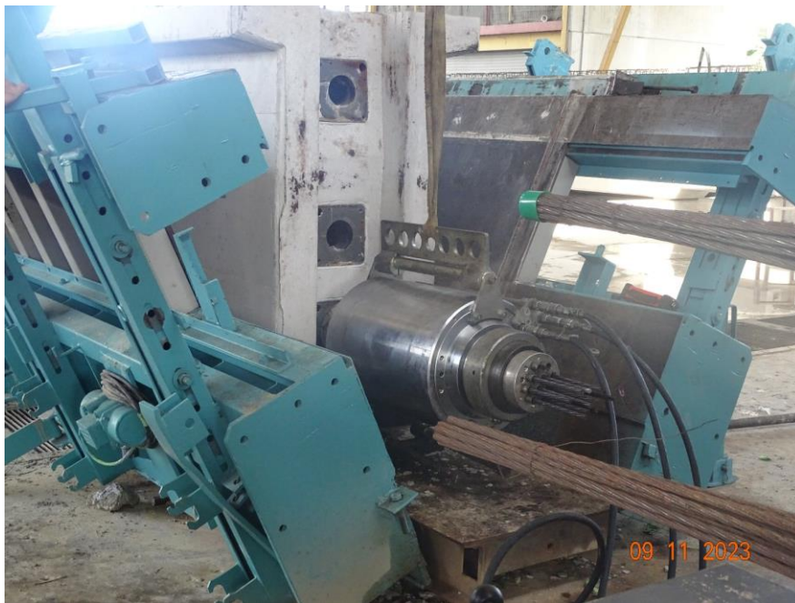
Figura 10. Proceso de tesado de ducto inferior de vigas de superestructura n.º 5
