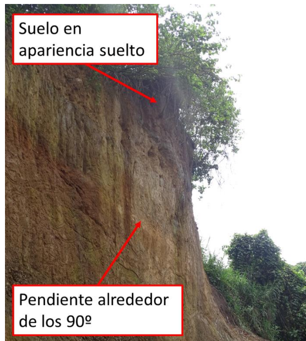
Figura 4. Talud adyacente a pila n.º 2 con pendiente mayor a 90° y suelo en apariencia suelto en la cúpula
