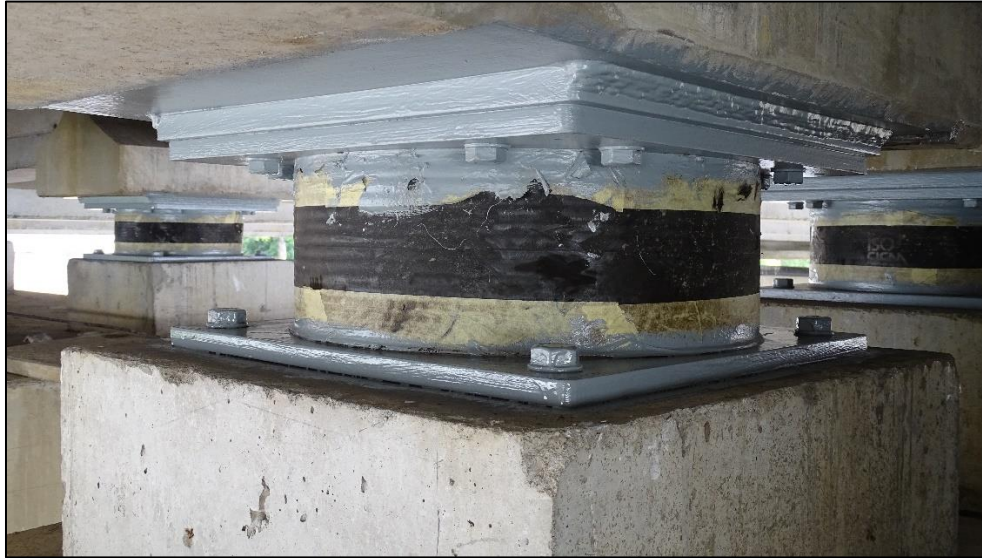
Figura 8. Sistema de protección que fue aplicado a las placas de acero de los dispositivos de apoyo del viaducto en las Unidades Funcionales III y IV del proyecto.
