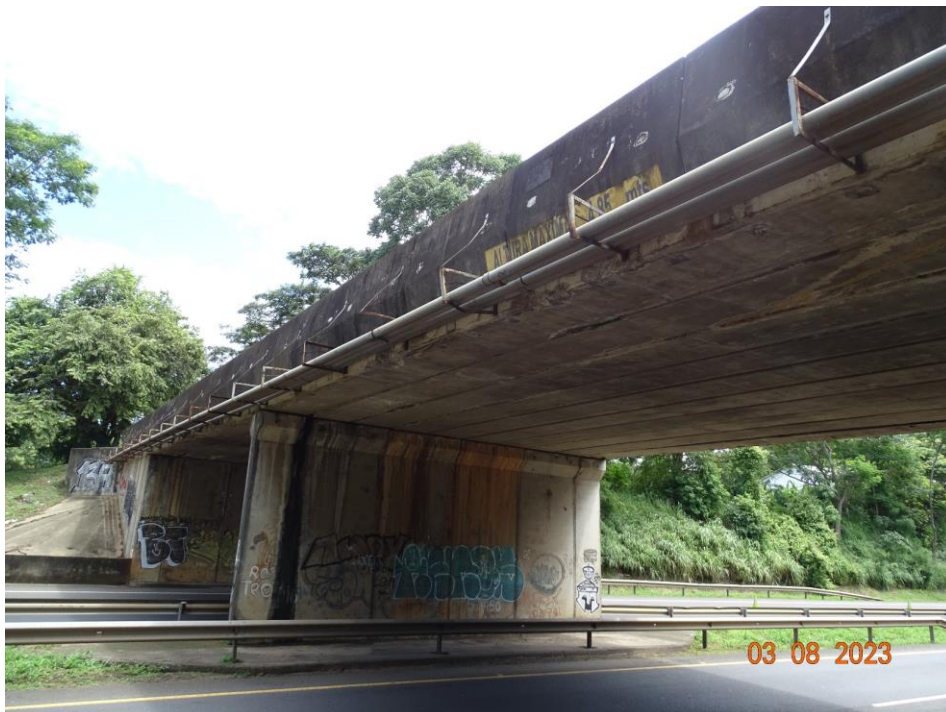
Figura 4.3. Vista lateral del costado noreste del puente
