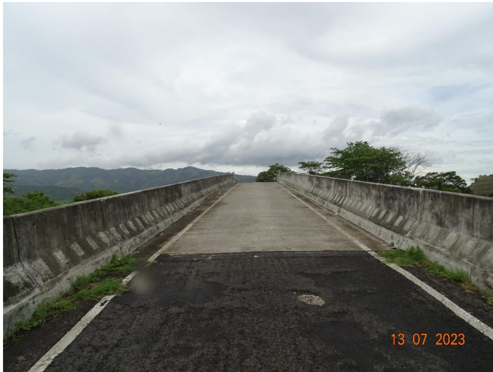
Figura 4.2. Vista a lo largo de la línea de centro del puente hacia acceso n.º 2
