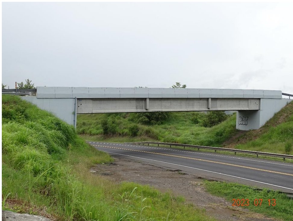
Figura 4.3. Vista lateral del costado oeste del puente
