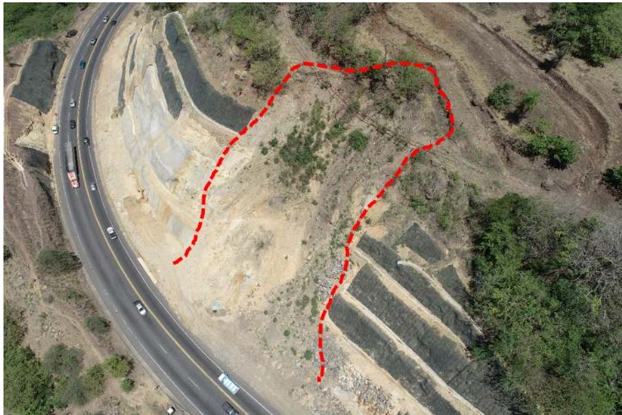
Figura 58. Vista aérea del talud de corte en el km 38+600 en abril del año 2023. Se observan diferentes materiales colocados para la protección superficial del talud y se destaca en línea roja el perímetro aproximado del deslizamiento que tiene lugar en el centro del talud que fue intervenido
