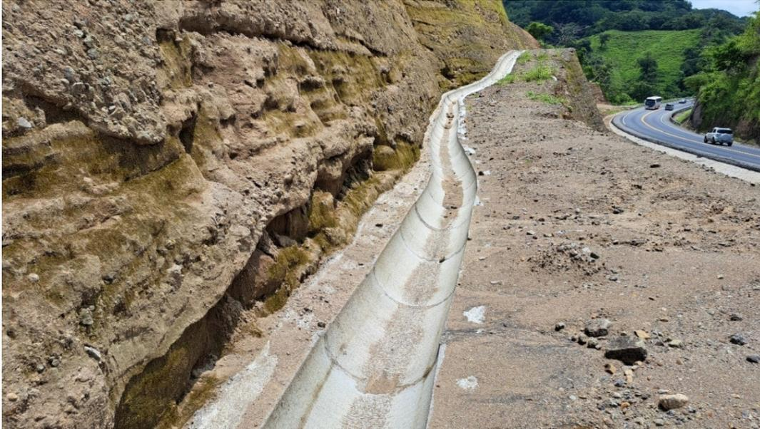
Figura 65. En este talud de corte del km 40+700 se observan los primeros indicios de erosión superficial, una parte del material erosionado se acumula en la cuneta de concreto
