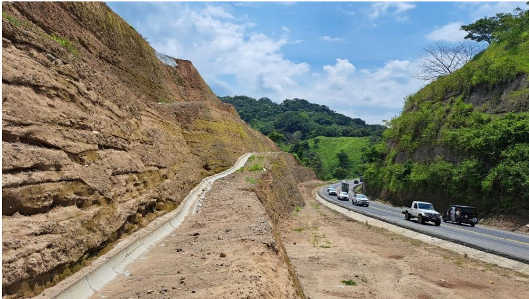
Figura 64. Talud de corte en el km 40+700 de la Ruta Nacional No.27, con secciones de berma y talud
