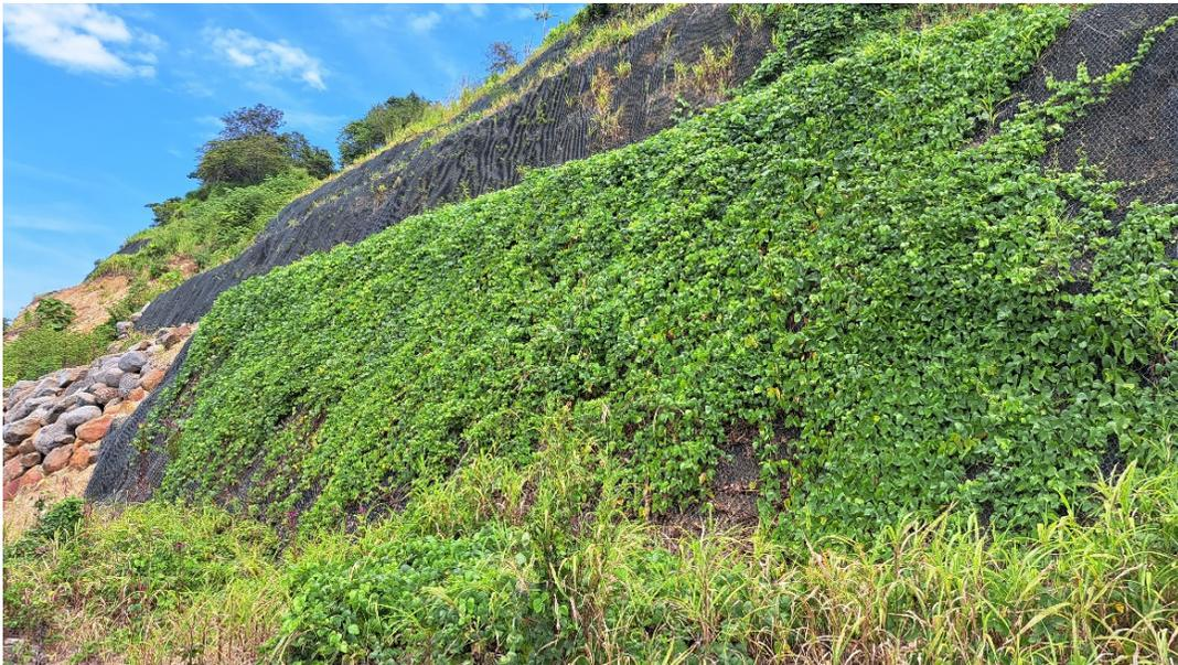
Figura 60. Sector al pie del talud en el km 38+600, con crecimiento de vegetación sobre el manto geosintético instalado
