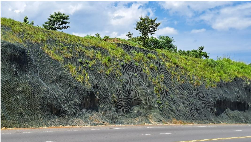
Figura 62. Talud de corte en el km 38+600 de la Ruta Nacional No.27. Se observa el manto para control de erosión instalado, así como vegetación que ha logrado establecerse en la parte alta del talud
