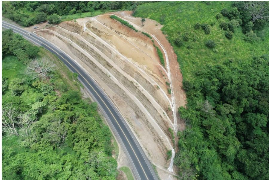
Figura 63. Vista aérea del talud de corte en el km 40+700 de la Ruta Nacional No.27, setiembre 2023. Se observan las nuevas secciones de taludes y bermas, producto de la más reciente intervención por parte del Concesionario
