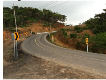
Demarcación horizontal deteriorada
