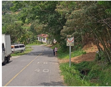
Señalamiento vertical obstruida por la vegetación
