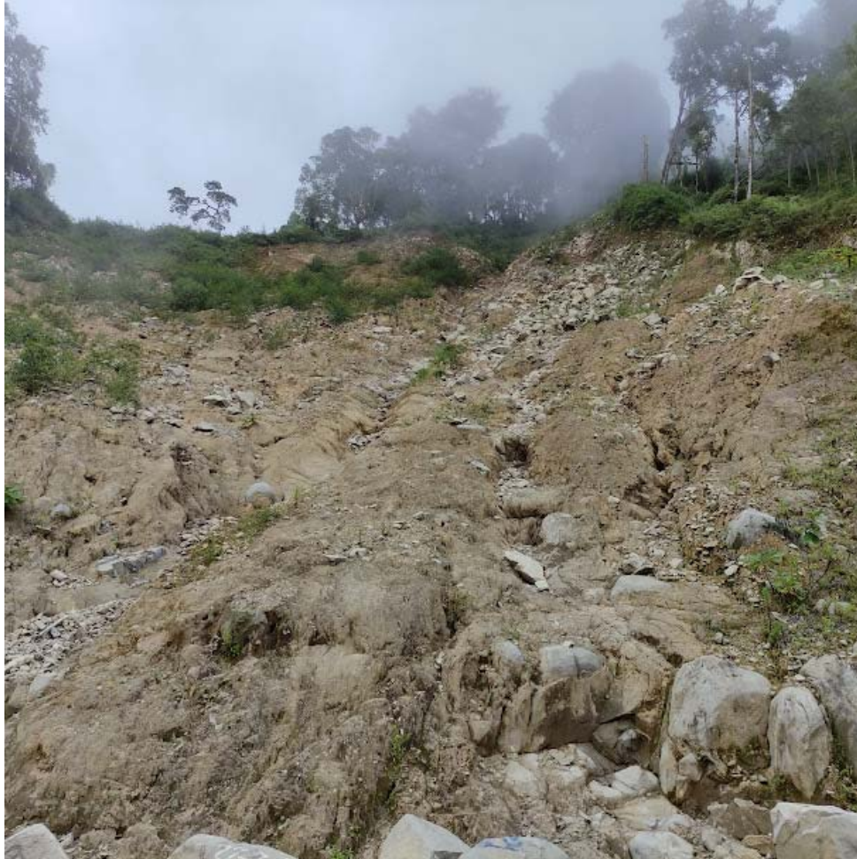
Figura 11. Condición del macizo rocoso observado en las proximidades del km 105+375 de la RN 2
