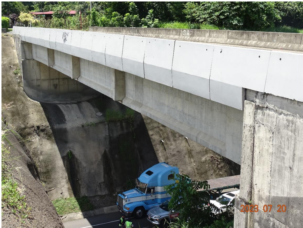
Figura 4.3. Vista lateral del costado oeste del puente
