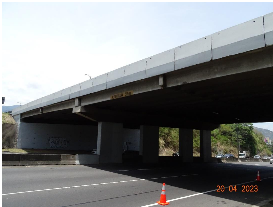
Figura 4.3. Vista lateral del costado este del puente
