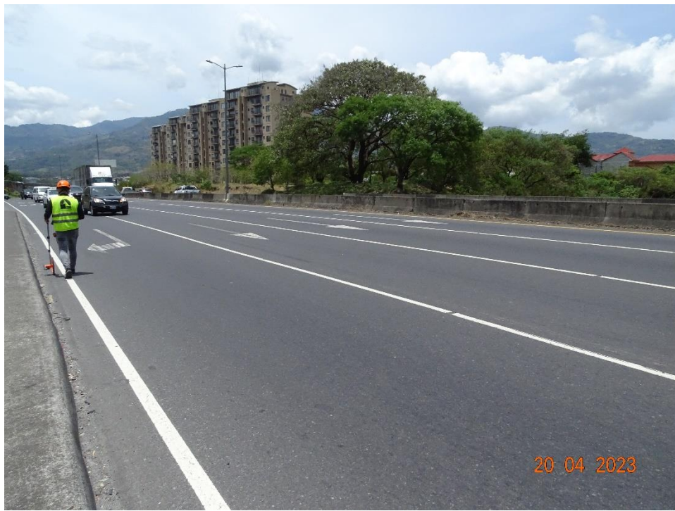
Figura 4.2. Vista a lo largo de la línea de centro del puente hacia Hatillo
