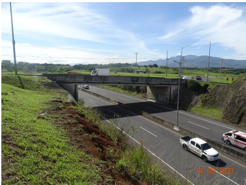
Figura 4.3. Vista lateral del costado oeste del puente
