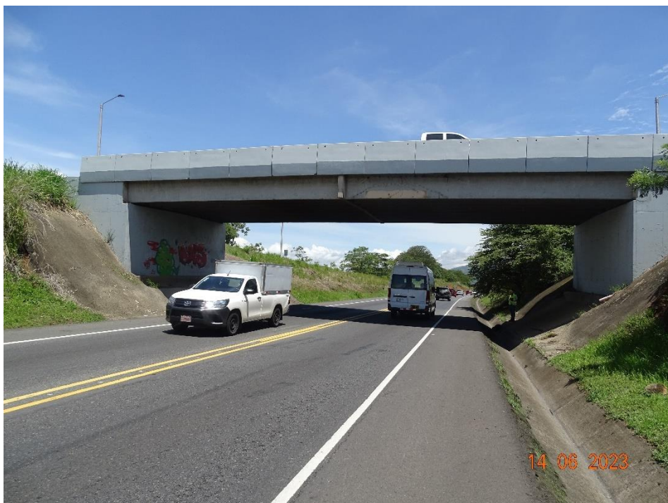
Figura 4.3. Vista lateral del costado este del puente
