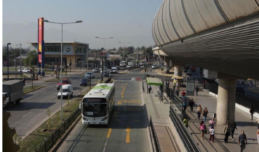
Figura 13. Infraestructura en zonas pagas
