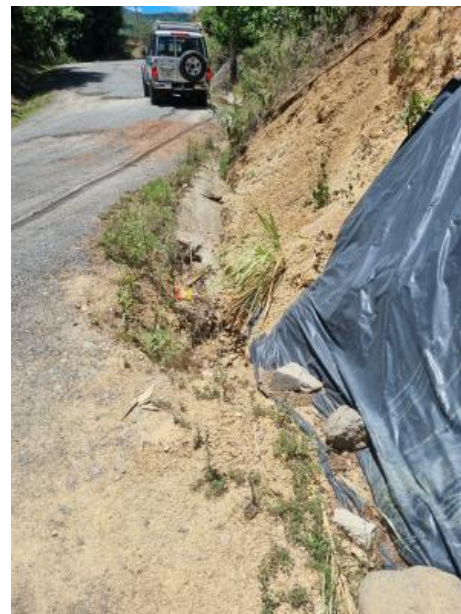
Figura 7. Punto 3, Ruta Nacional No.206. Deslizamiento en talud al costado derecho de la vía (sentido San Miguel – Corralillo).
