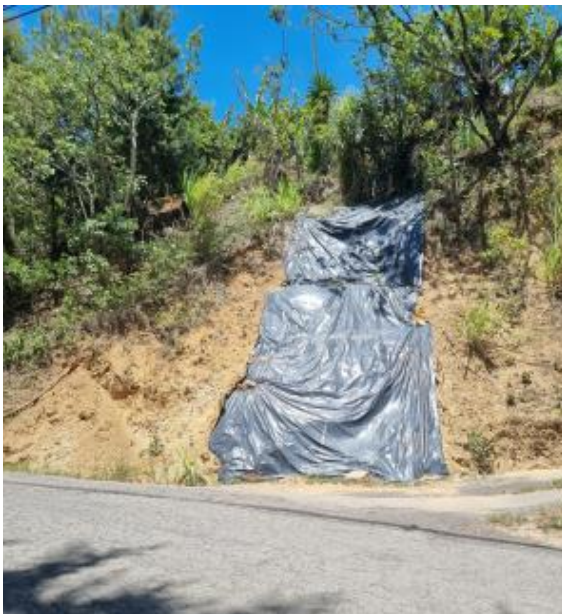
Figura 7. Punto 3, Ruta Nacional No.206. Deslizamiento en talud al costado derecho de la vía (sentido San Miguel – Corralillo).
