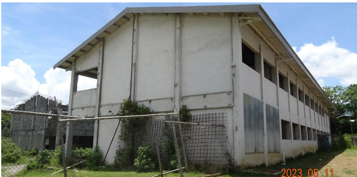
Figura 5. Vista panorámica exterior posterior del grado de avance constructivo del edificio de aulas No.3 del CTP José María Zeledón Brenes
