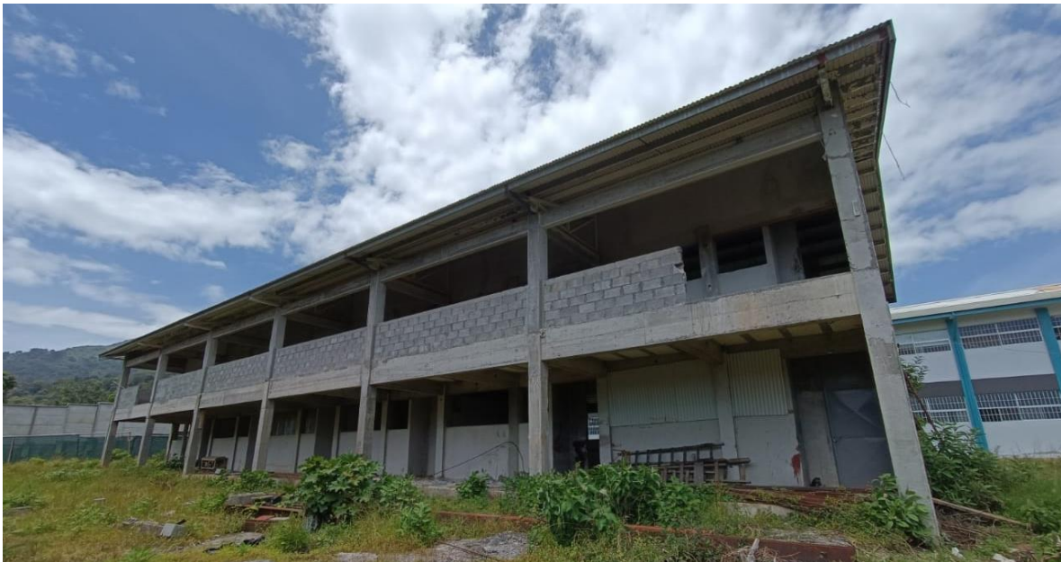
Figura 4. Vista panorámica exterior frontal del grado de avance constructivo del edificio de aulas No.3 del CTP José María Zeledón Brenes
