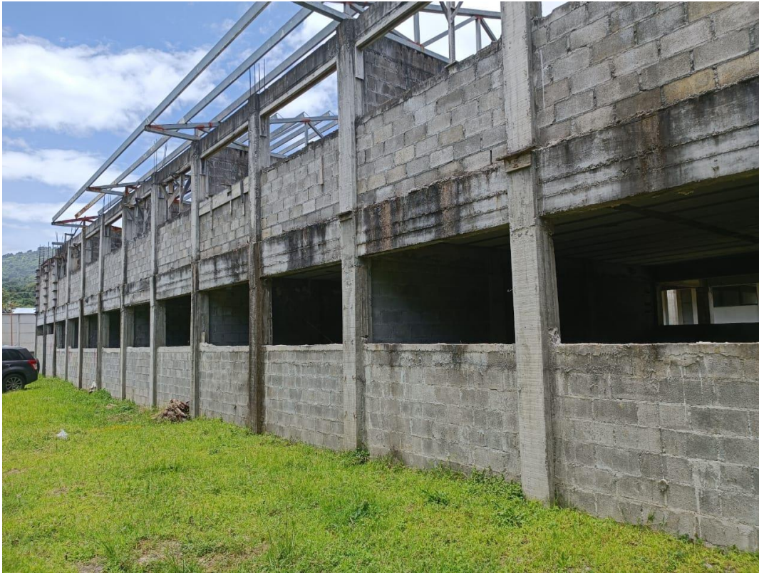
Figura 10. Vista panorámica exterior posterior del grado de avance constructivo del edificio de aulas No.4 del CTP José María Zeledón Brenes
