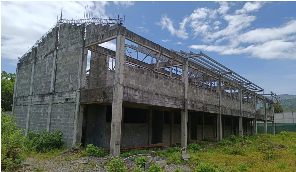
Figura 9. Vista panorámica exterior frontal del grado de avance constructivo del edificio de aulas No.4 del CTP José María Zeledón Brenes
