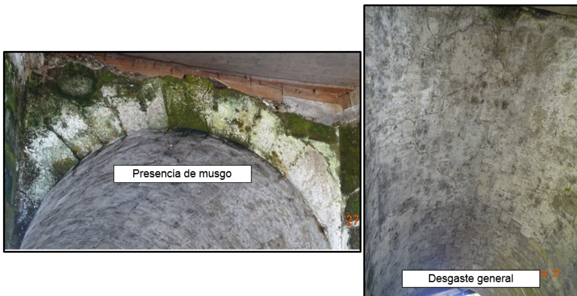
Figura 4. Presencia de musgo y desgaste general del arco de mampostería del puente del río Pirro
