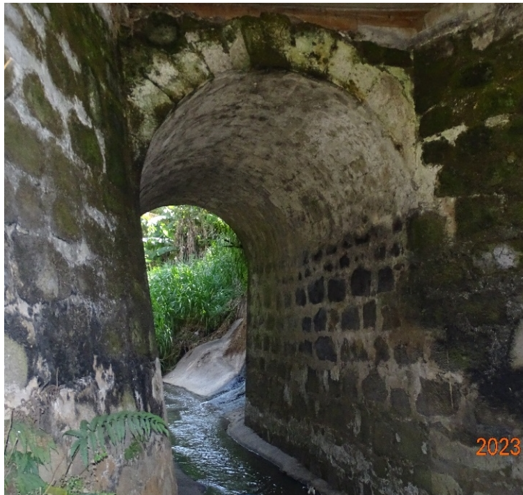
Figura 1. Superestructura original del puente con arco de mampostería Fuente: LanammeUCR, 2023.
