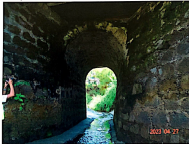
Figura 6. Vista del puente, en dirección hacia aguas arriba. Se observan muros de mampostería que protegen rellenos de aproximación, un arco simple de mampostería de aproximadamente 3 m de ancho, y un recubrimiento de concreto lanzado en el fondo del cauce. Se ve poca pendiente de fondo. La estructura moderna que sostiene la Ruta Nacional 3 se observa sobre el arco. La estructura en mampostería es angosta y se puede considerar como una alcantarilla.
