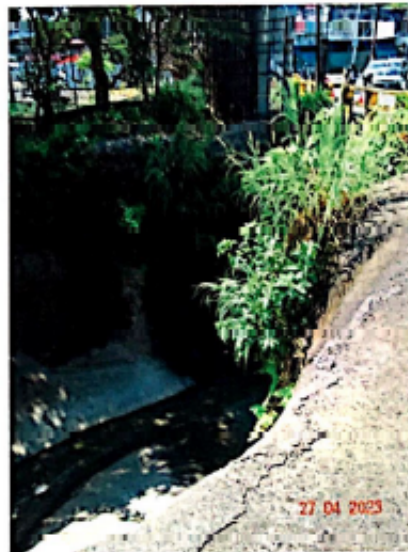
Figura 3. Vista de la entrada al puente. Se aprecia que el revestimiento de concreto lanzado cubre el fondo del cauce. Sobre la margen izquierda se observa un muro de mampostería sobre el cual crece algo de vegetación.
