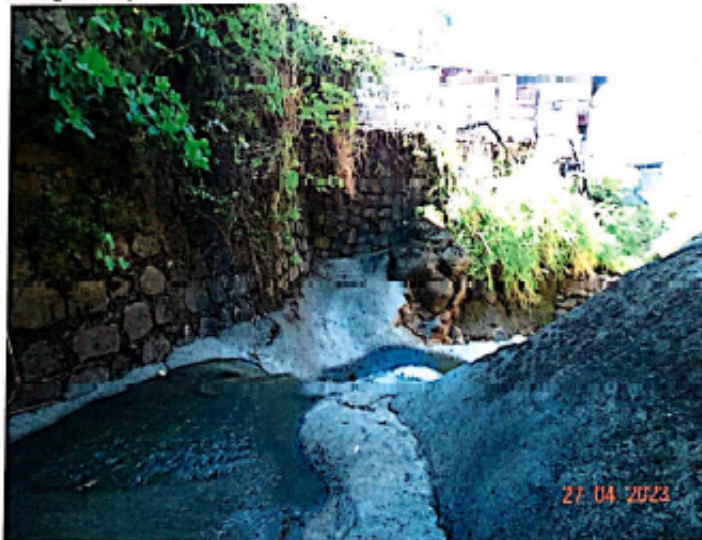
Figura 4. Salida del puente. Se observa una configuración similar a la observada aguas arriba, con un revestimiento de concreto lanzado en el fondo y margen derecha del cauce, y un muro de mampostería que protege la margen izquierda. Además se aprecia una caída del nivel de fondo.
