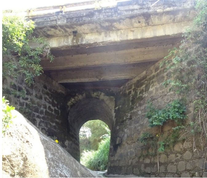
Figura 2. Superestructura secundaria del puente mediante vigas de concreto reforzado Fuente: LanammeUCR, 2023.
