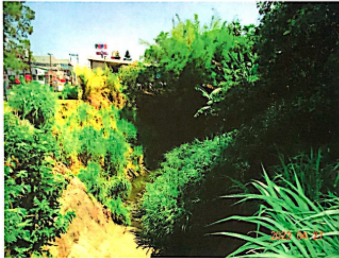
Figura 2. Vista desde el puente en dirección aguas arriba. Se observa un cauce con laderas empinadas y vegetadas que se reemplaza por una sección revestida de concreto en la margen derecha del río. La pendiente de fanda es baja y se observan agua empozada.
