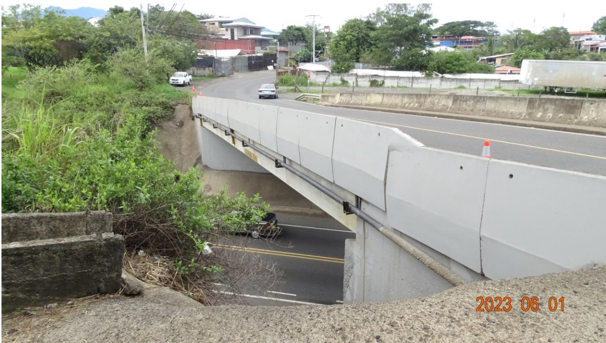
Figura 4.3. Vista lateral del costado este del puente
