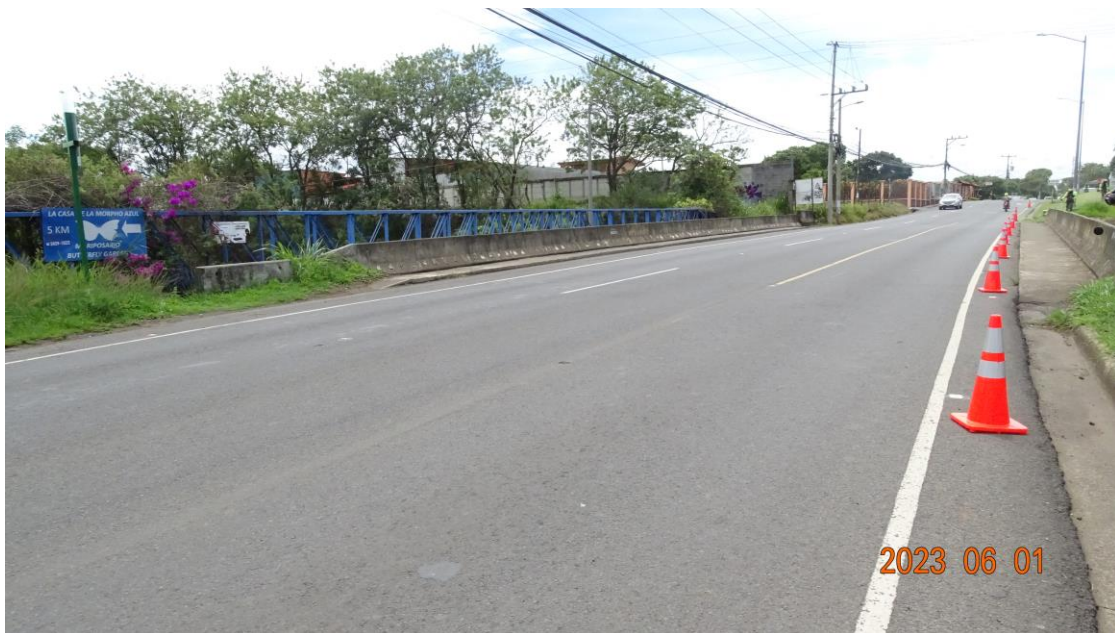
Figura 4.2. Vista a lo largo de la línea de centro del puente hacia el este
