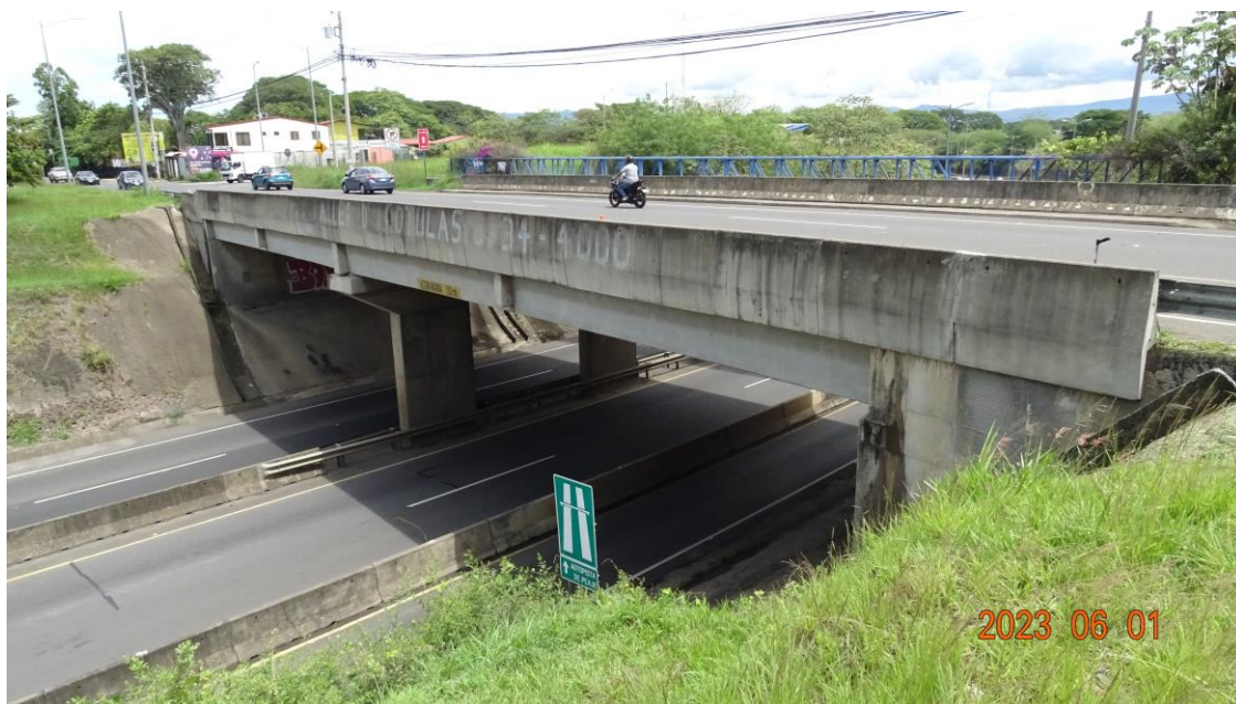
Figura 4.3. Vista lateral del costado sur del puente
