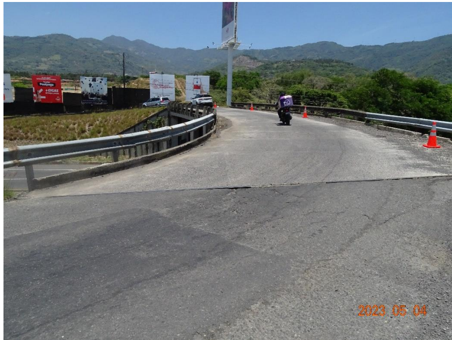
Figura 4.2. Vista a lo largo de la línea de centro del puente hacia San José
