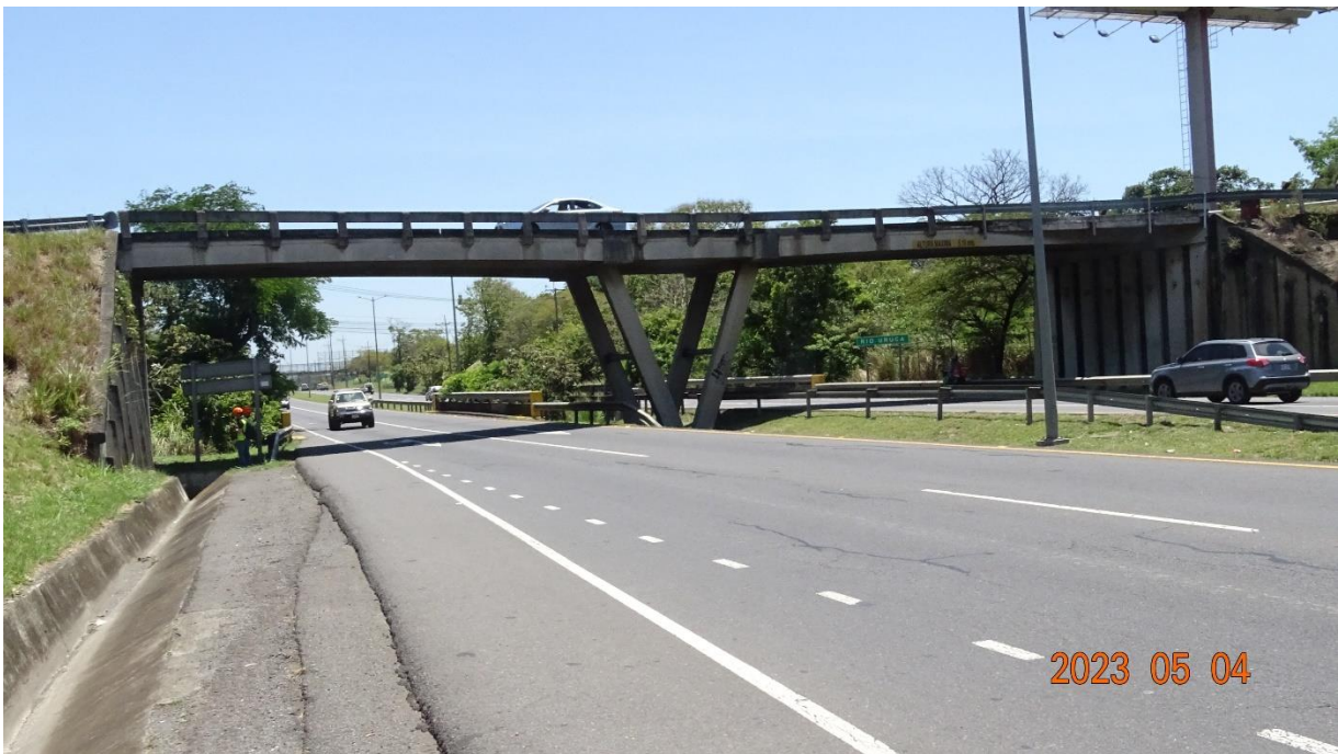
Figura 4.3. Vista lateral del costado este del puente
