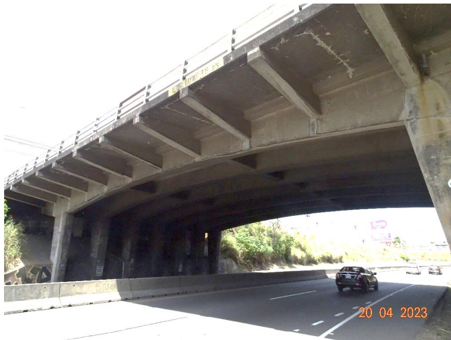
Figura 4.3. Vista lateral del costado este del puente
