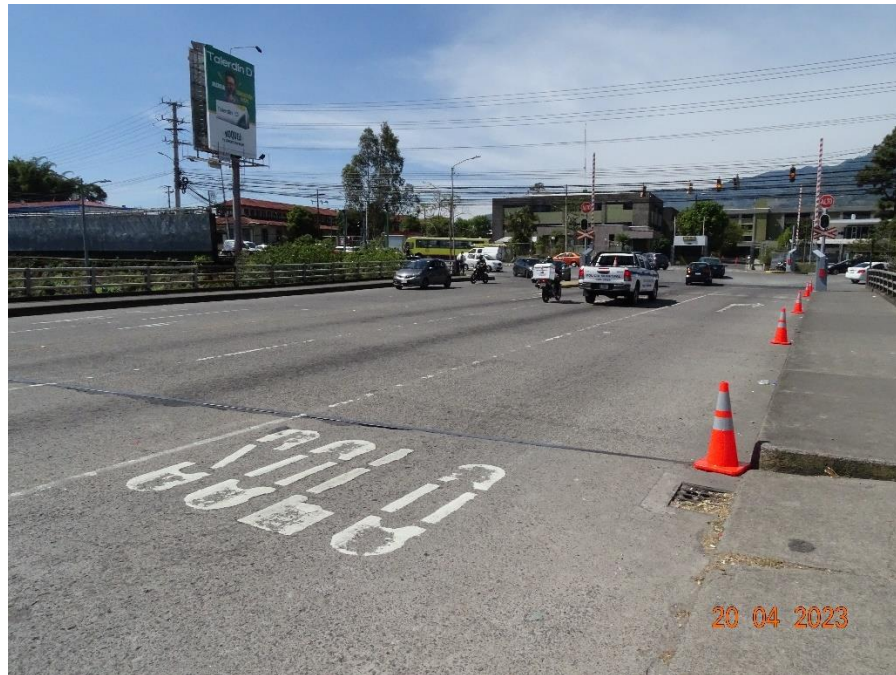
Figura 4.2. Vista a lo largo de la línea de centro del puente hacia Sabana Sur
